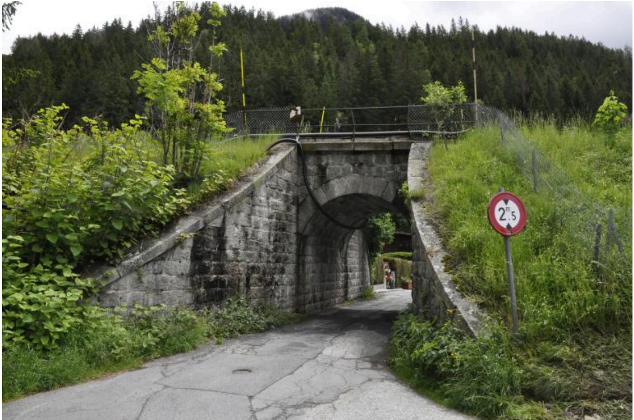
Vue générale du passage supérieur prise depuis le chemin des Jorasses
