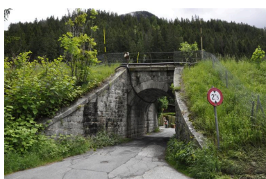
Vue générale du passage supérieur prise depuis le chemin des Jorasses Phot. Samir Mahfoudi IVR84_20207401191NUCA
