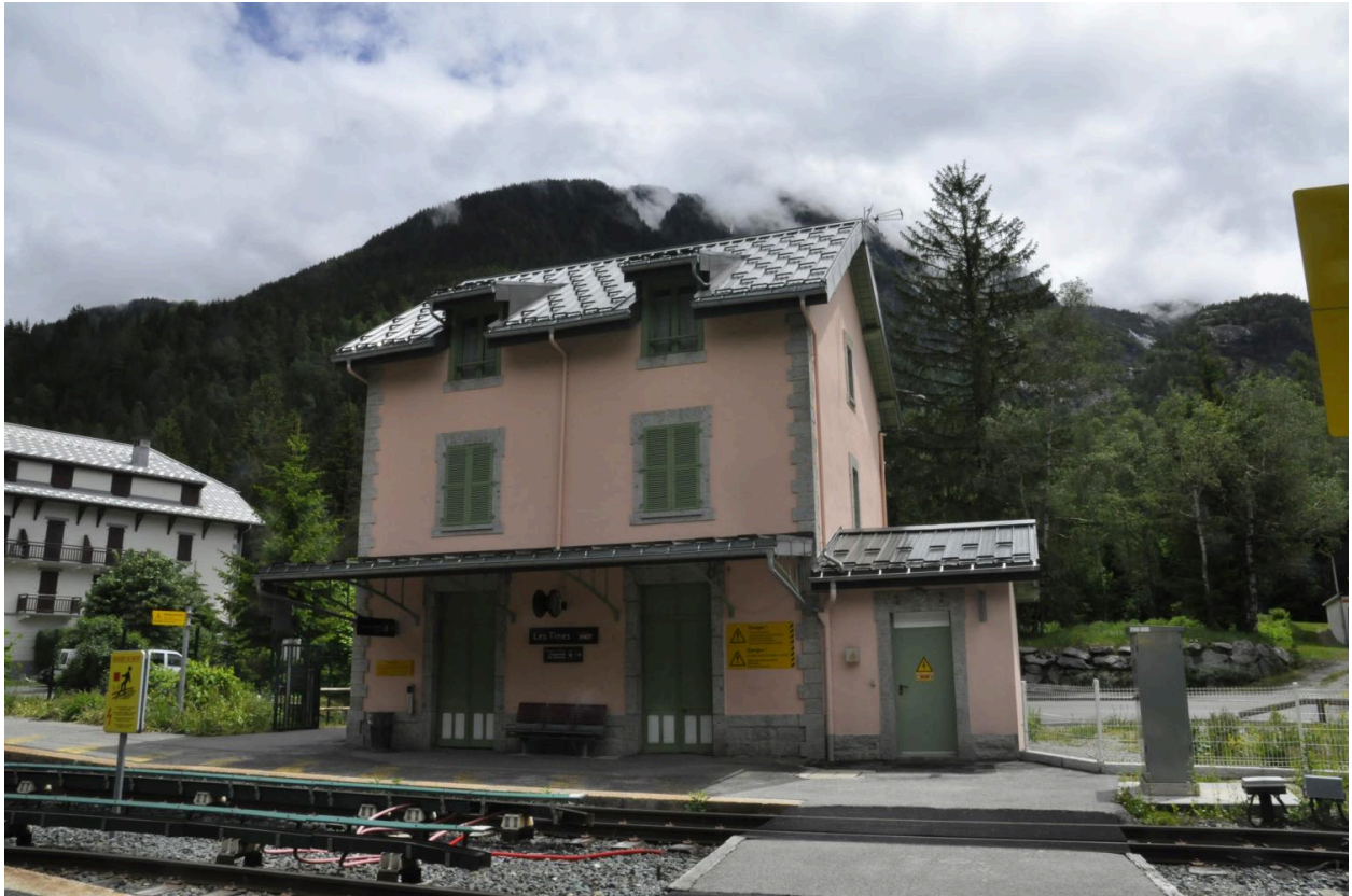
Vue de la façade postérieure du bâtiment de la halte des Tines situé 460 mètres au sud-ouest du pont
