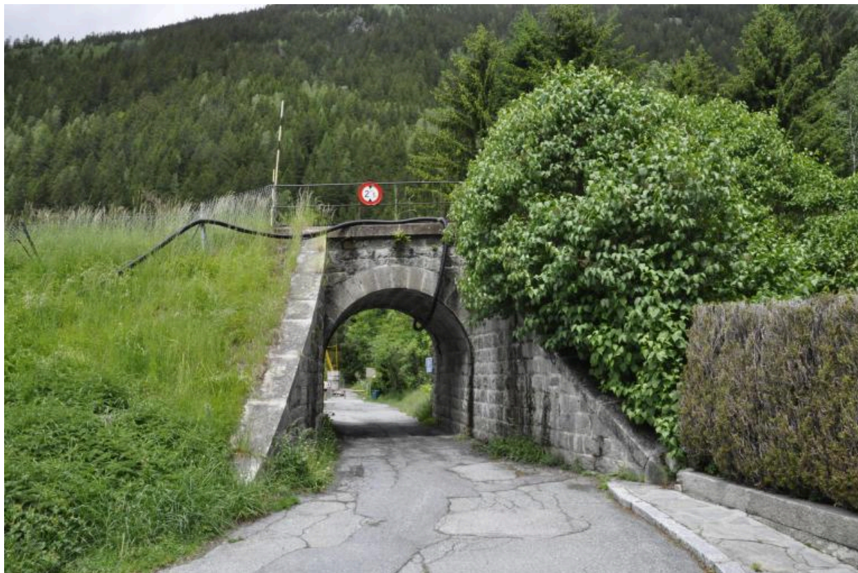
Vue de la face est du passage supérieur
