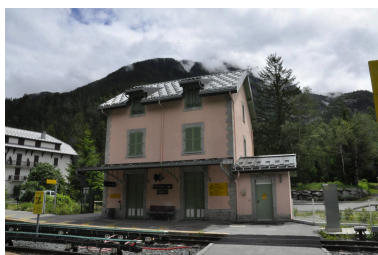
Vue de la façade postérieure du bâtiment de la halte des Tines situé 460 mètres au sud-ouest du pont Phot. Samir Mahfoudi IVR84_20207401195NUCA
