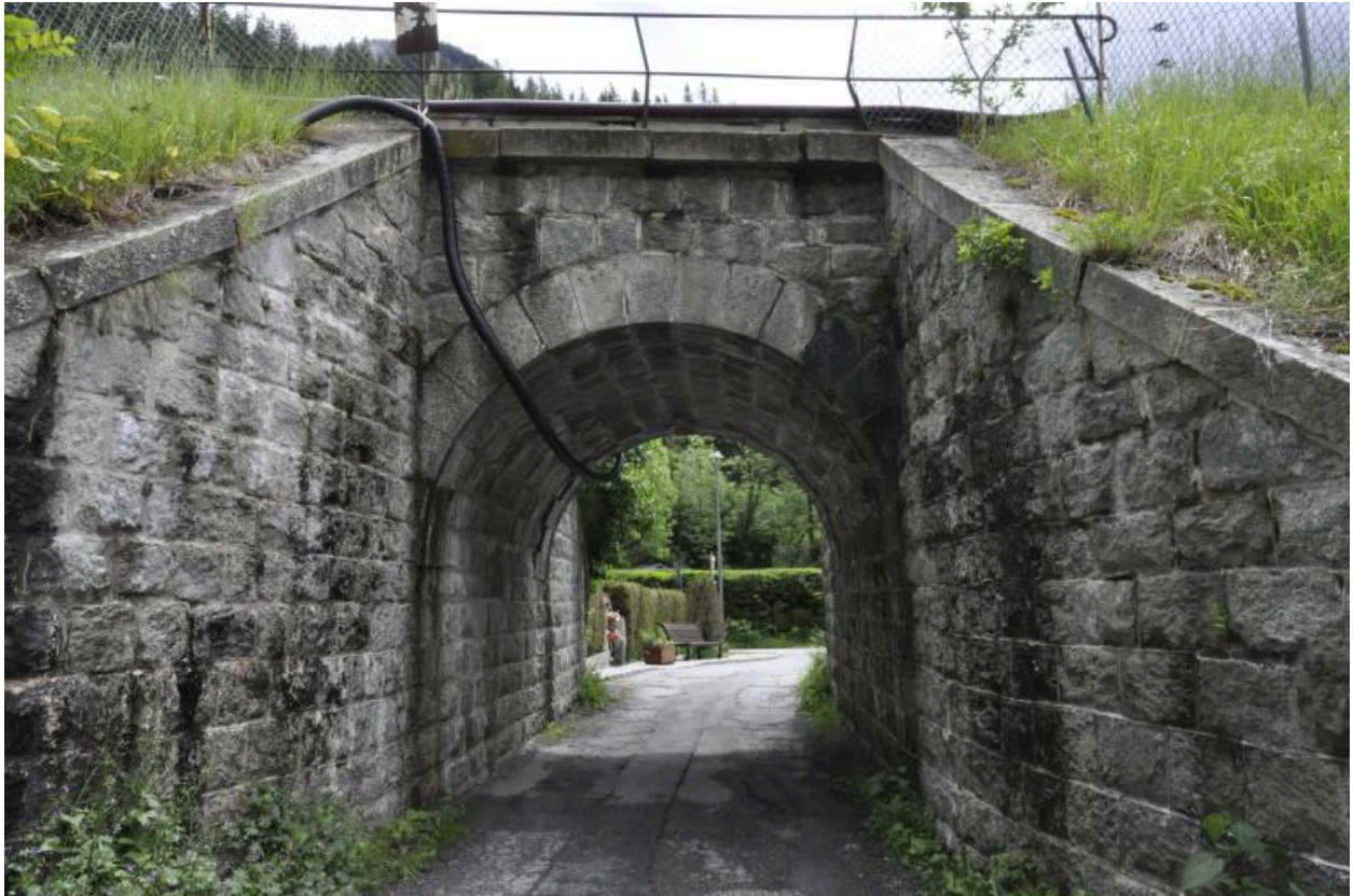
Vue de la face nord-ouest du passage supérieur
