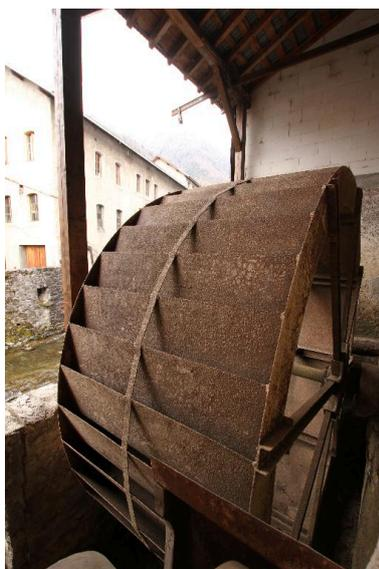
Adossée au mur de la chapelle, la roue à augets est protégée par le soutènement des eaux du Foron
