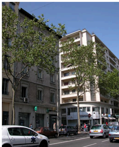
Vue partielle depuis le nord-est Phot. Maryannick Chalabi IVR82_20046904663NUCA
