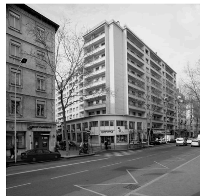
Vue d'ensemble depuis le nord-est Phot. Eric Dessert IVR82_20056900637NUC
