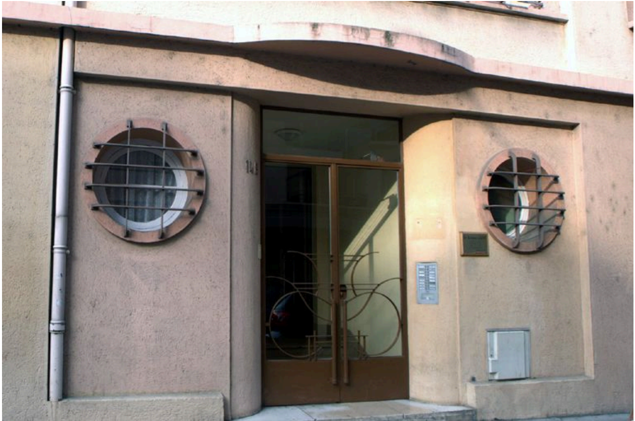
Elévation principale, détail de l'entrée
