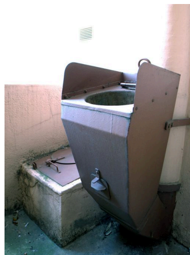
Vide-ordure extérieur Phot. Maryannick Chalabi IVR82_20106905025NUCA
