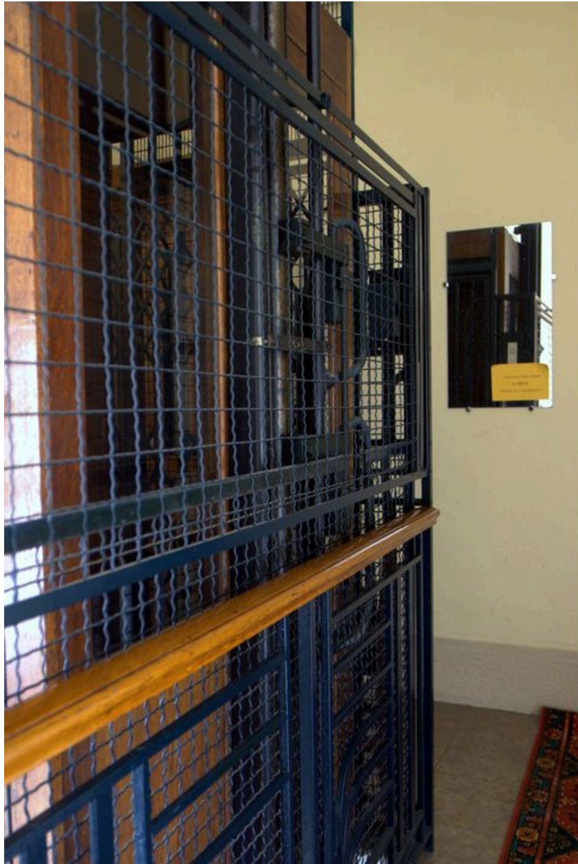
Cage d'ascenseur, détail de la grille
