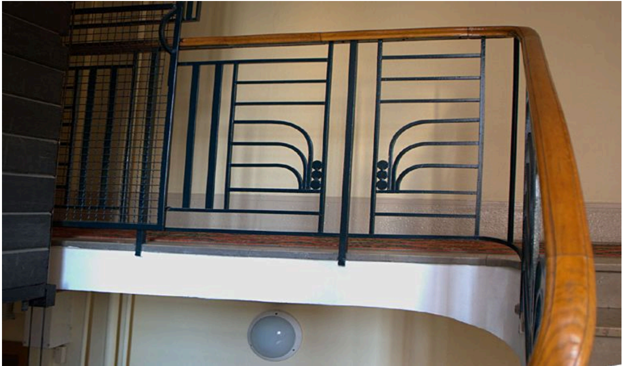
Escalier, détail de la rampe en fer forgé
