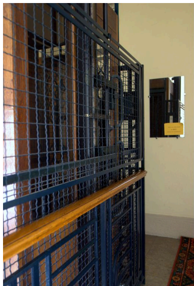
Cage d'ascenseur, détail de la grille Phot. Maryannick Chalabi IVR82_20106903597NUCA
