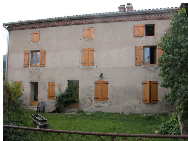
Vue générale Phot. Thierry Monnet IVR82_20124200797NUCA
