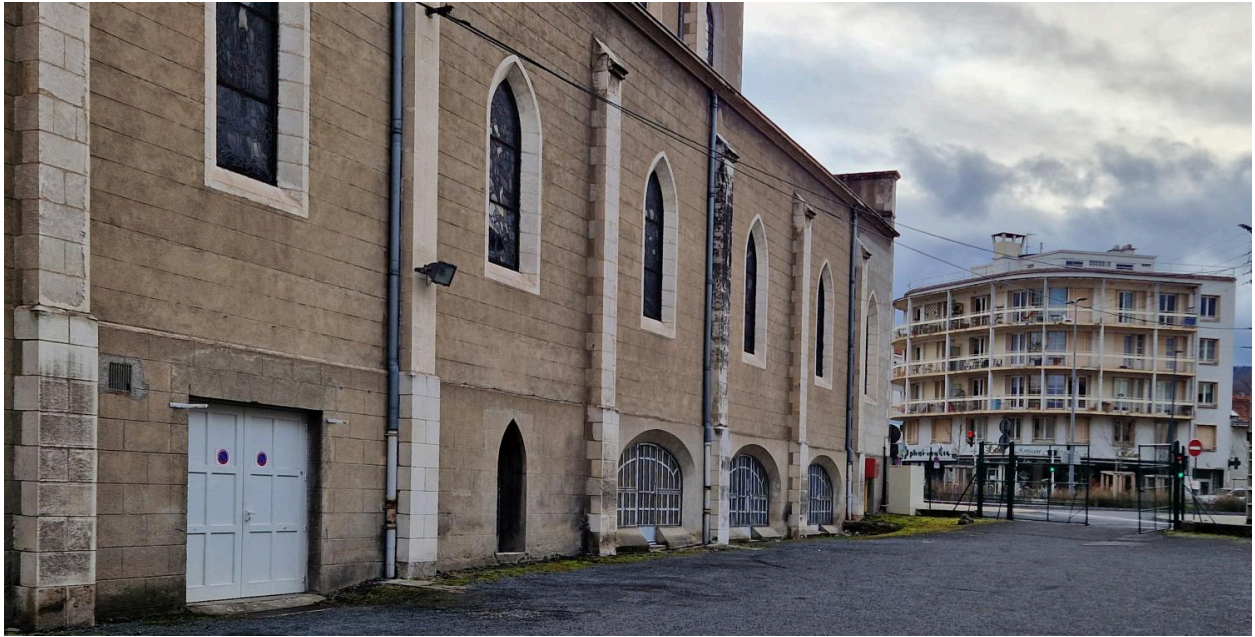
Flanc nord de l'église sainte Jean-d'Arc. A l'arrière-plan, façade de l'immeuble n°65 boulevard Jean-Jaurès (V. Vigneron architecte)
