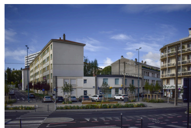
Élévation des bâtiments au sud de la place Littré. Mur d'héberge de l'immeuble placé latéralement et rattrapage de l'alignement par une construction basse. Phot. Félicie Fougère IVR84_20256300307NUCA
