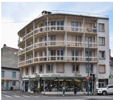
Élévation latérale sur le boulevard Jean-Jaurès Phot. Félicie Fougère IVR84_20256300308NUCA
