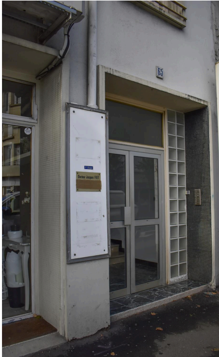
Porte sur le boulevard Jean-Jaurès
