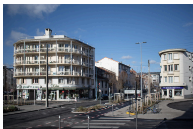
Boulevard Jean-Jaurès depuis la place Littré Phot. Félicie Fougère IVR84_20256300541NUCA
