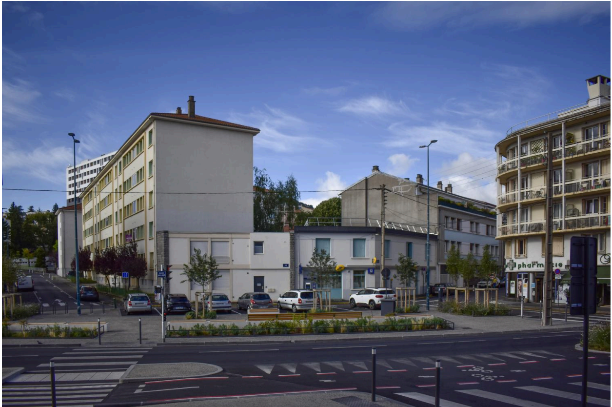
Elévation des bâtiments au sud de la place Littré. Mur d'héberge de l'immeuble placé latéralement et rattrapage de l'alignement par une construction basse.
