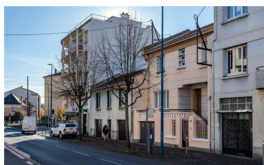
Façades sur le boulevard Jean-Jaurès Phot. Michel Pérès IVR84_20256302595NUCA
