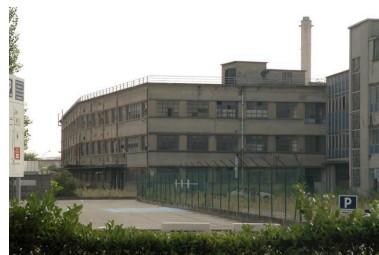
Bâtiment avant démolition Phot. Nadine Halitim-Dubois IVR82_20066900343NUCA
