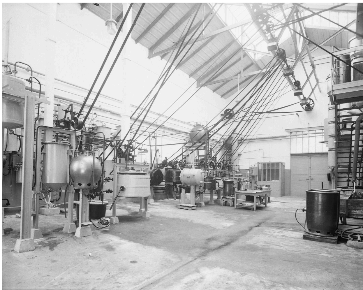
Vue d'intérieur Rhône-Poulenc usine 1930 (BML : P0546 S 1124)
