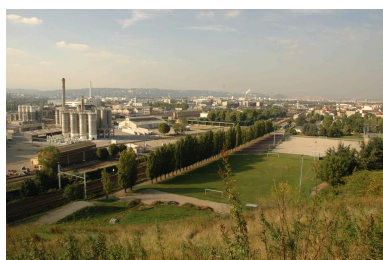
Vue d'ensemble sud-est Phot. Nadine Halitim-Dubois IVR82_20066900348NUCA
