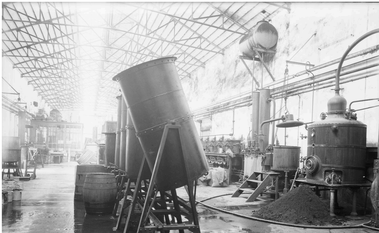
Vue d'intérieur Rhône-Poulenc usine 1910 (BML : P0546 S 1692)
