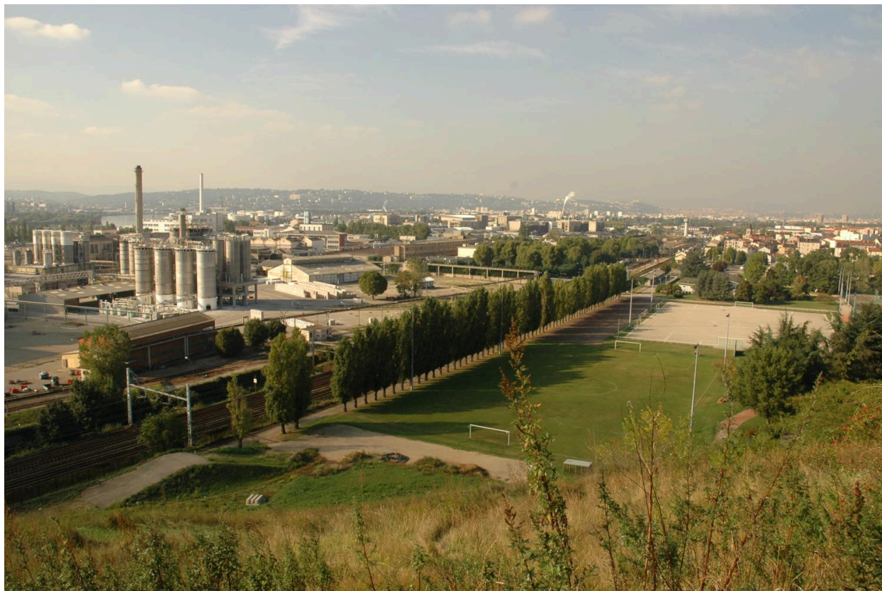
Vue d'ensemble sud-est
