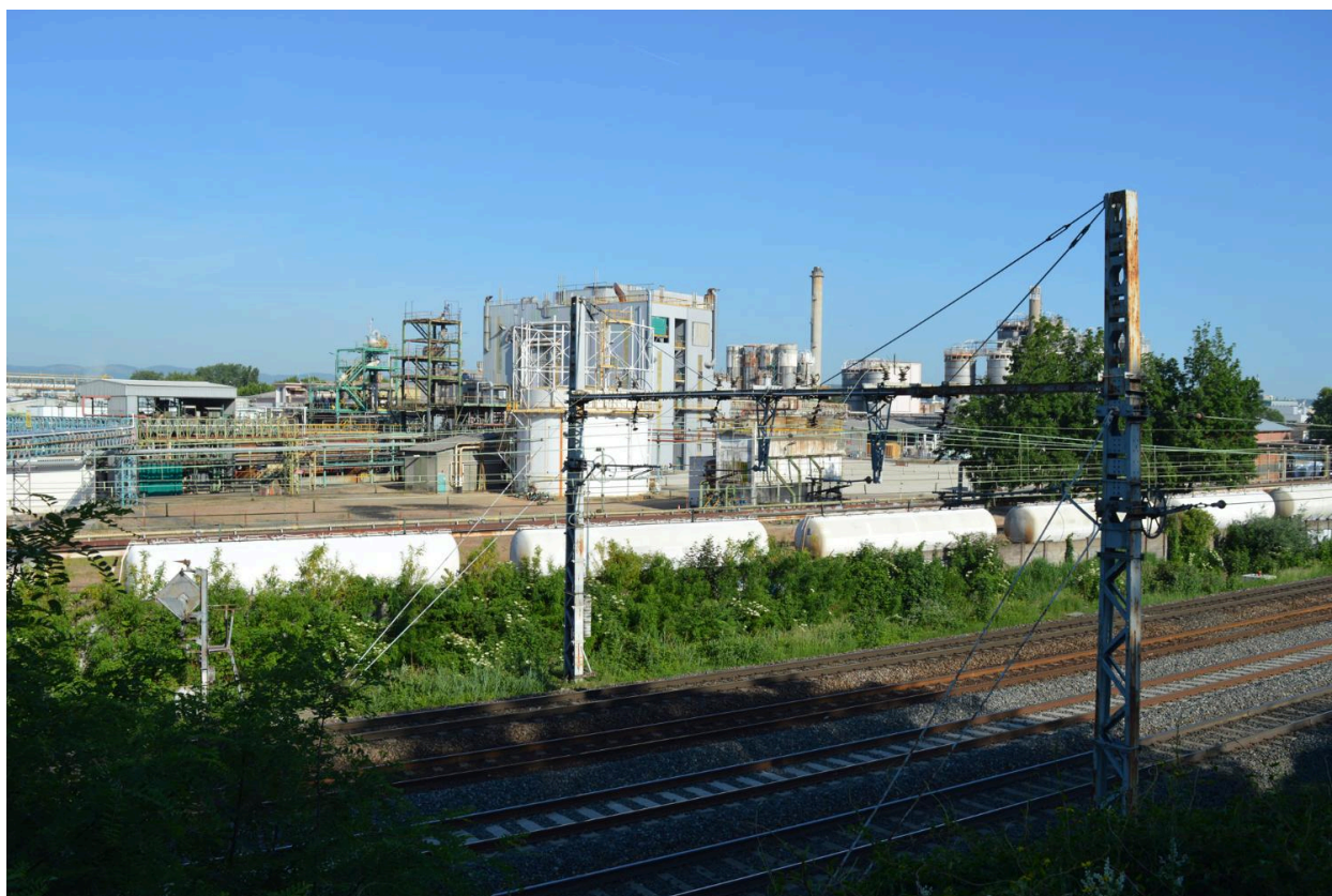
Vue côté raccordement ferroviaire
