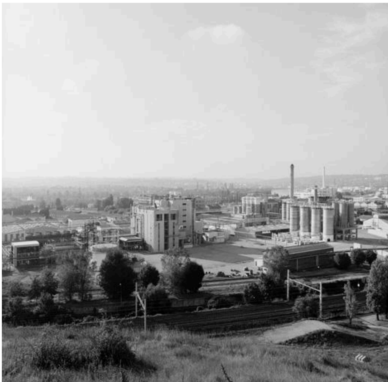
Vue d'ensemble des installations
