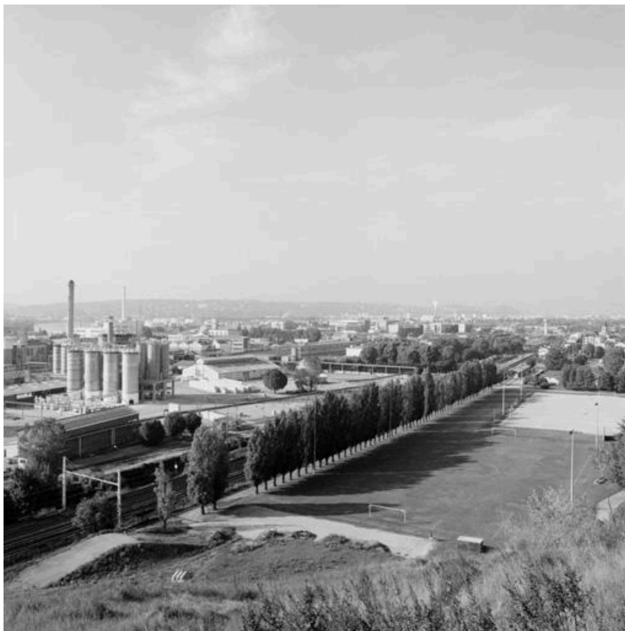
Vue d'ensemble des installations
