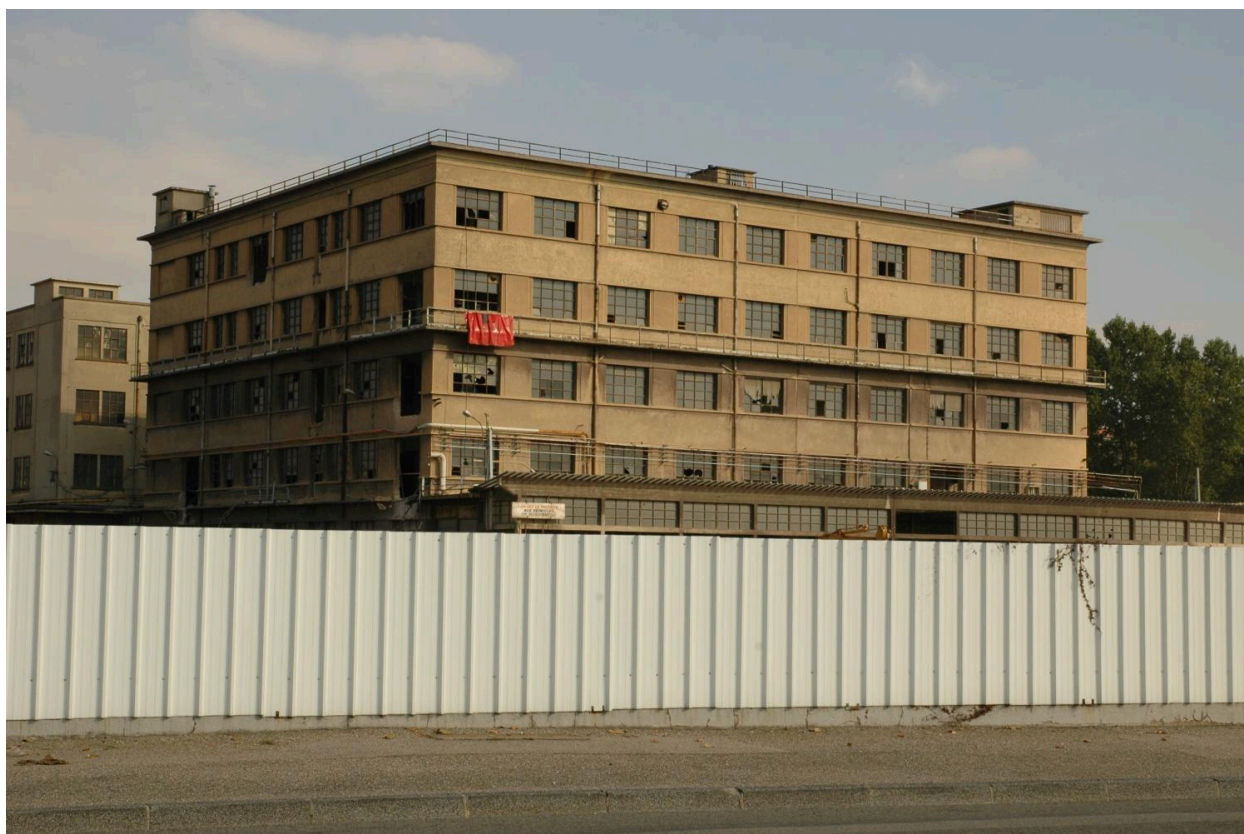
Détail bâtiment avant démolition
