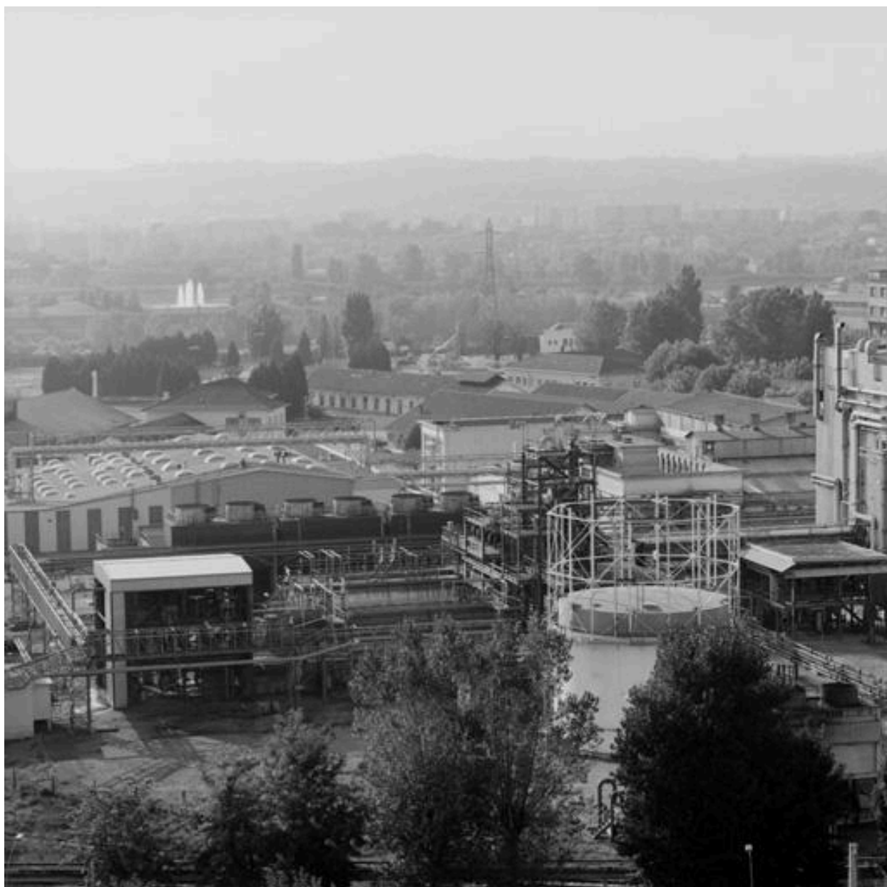
Vue d'ensemble est
