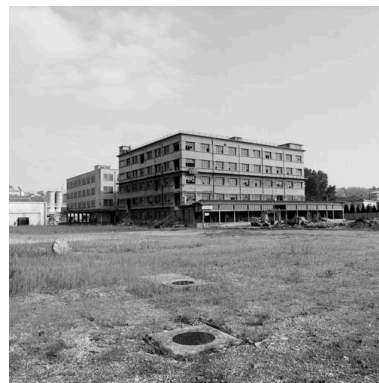
Bâtiment avant démolition Phot. Didier Gourbin IVR82_20056902936X
