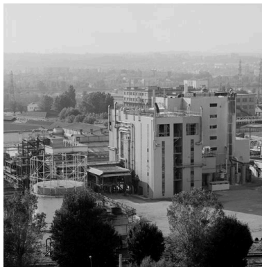
Vue des installations Phot. Didier Gourbin IVR82_20056902939X
