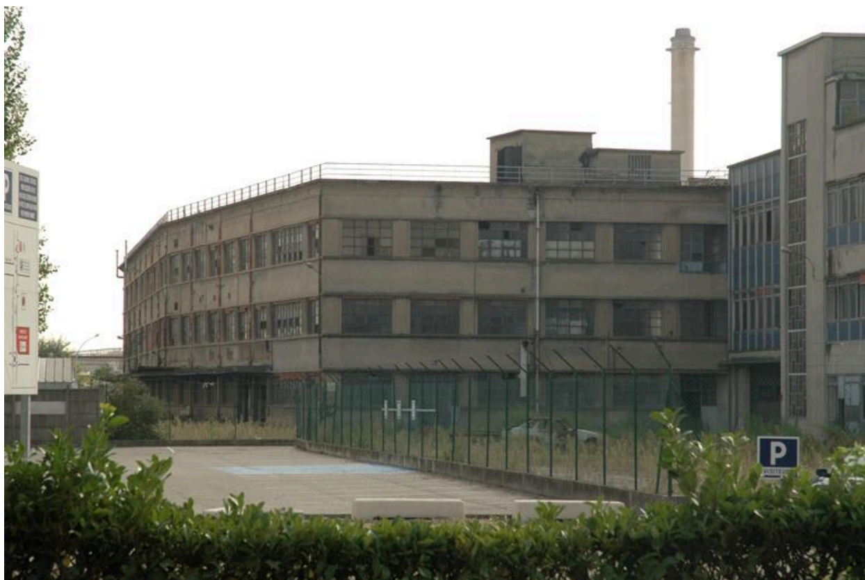
Bâtiment avant démolition
