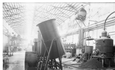
Vue d'intérieur Rhône-Poulenc usine 1910 (BML : P0546 S 1692) Phot. Jules Sylvestre IVR84_20256900083NUC
