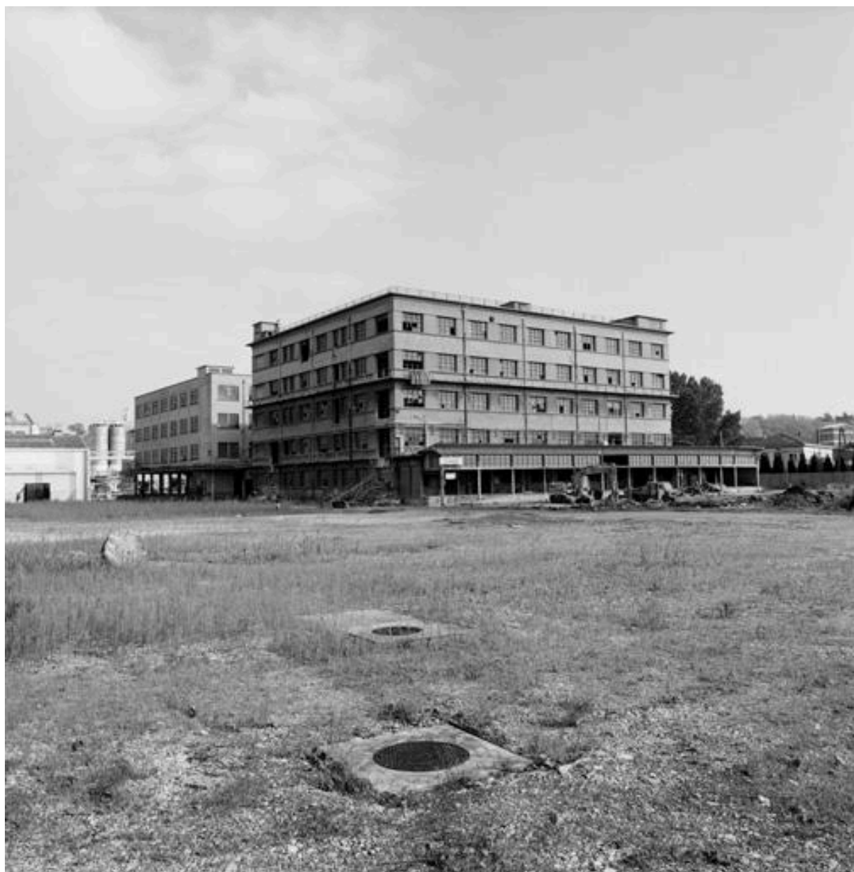
Bâtiment avant démolition
