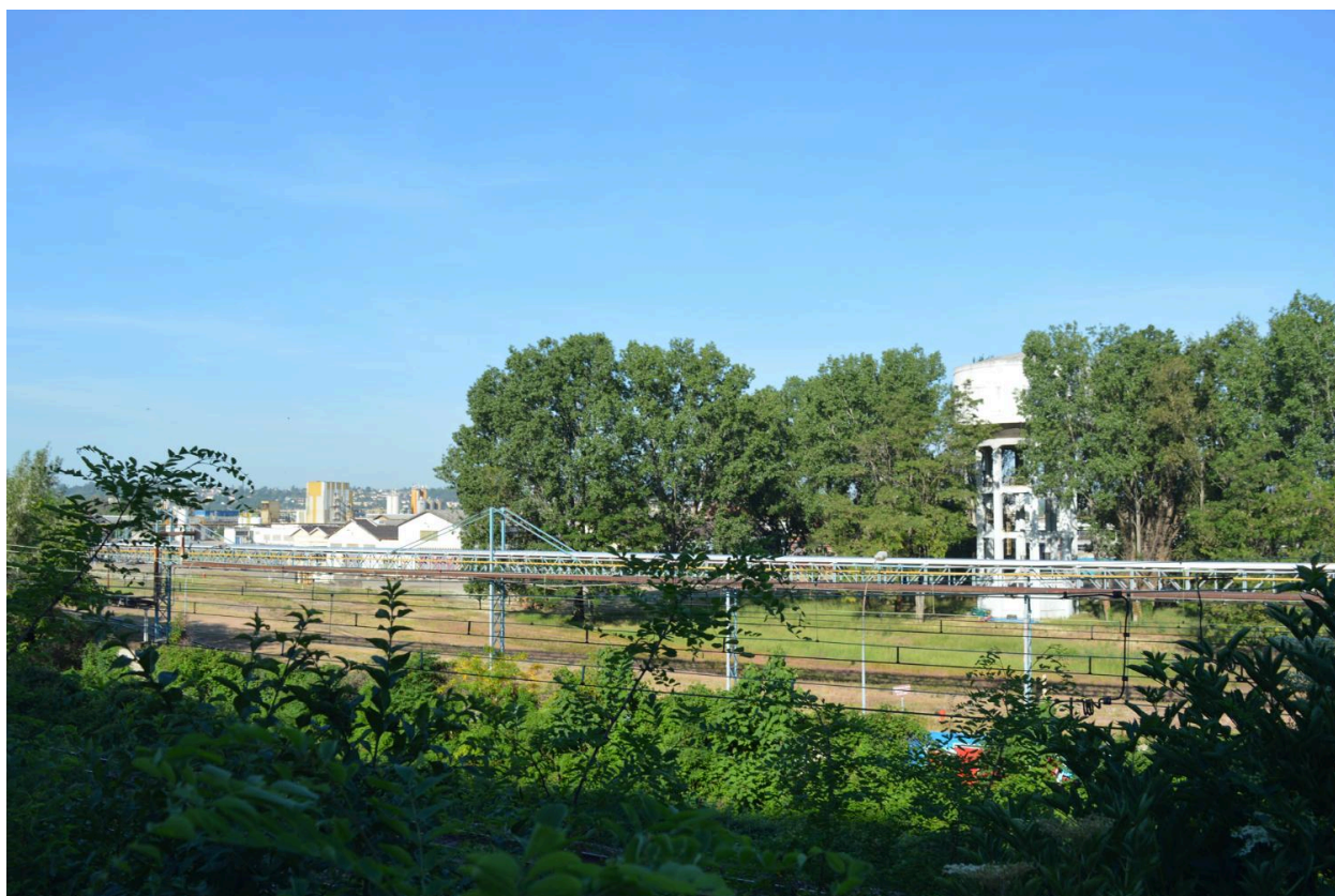
Vue des circulation aérienne (pipeline)
