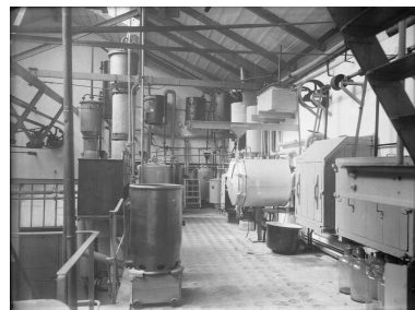
Vue d'intérieur Rhône-Poulenc usine 1930 (BML : P0546 S 1120) Phot. Jules Sylvestre IVR84_20256900074NUC
