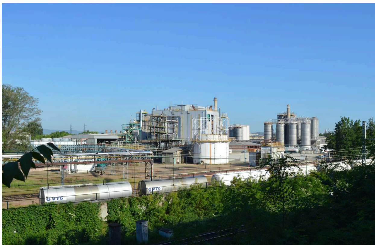
Vue est du site côté voie ferrée
