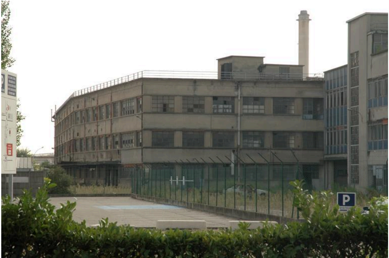
Bâtiment avant démolition
