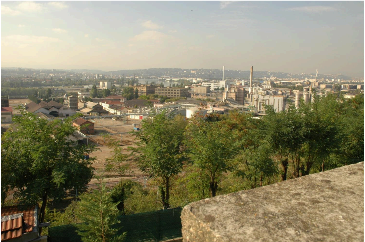
Vue d'ensemble du couloir de la chimie
