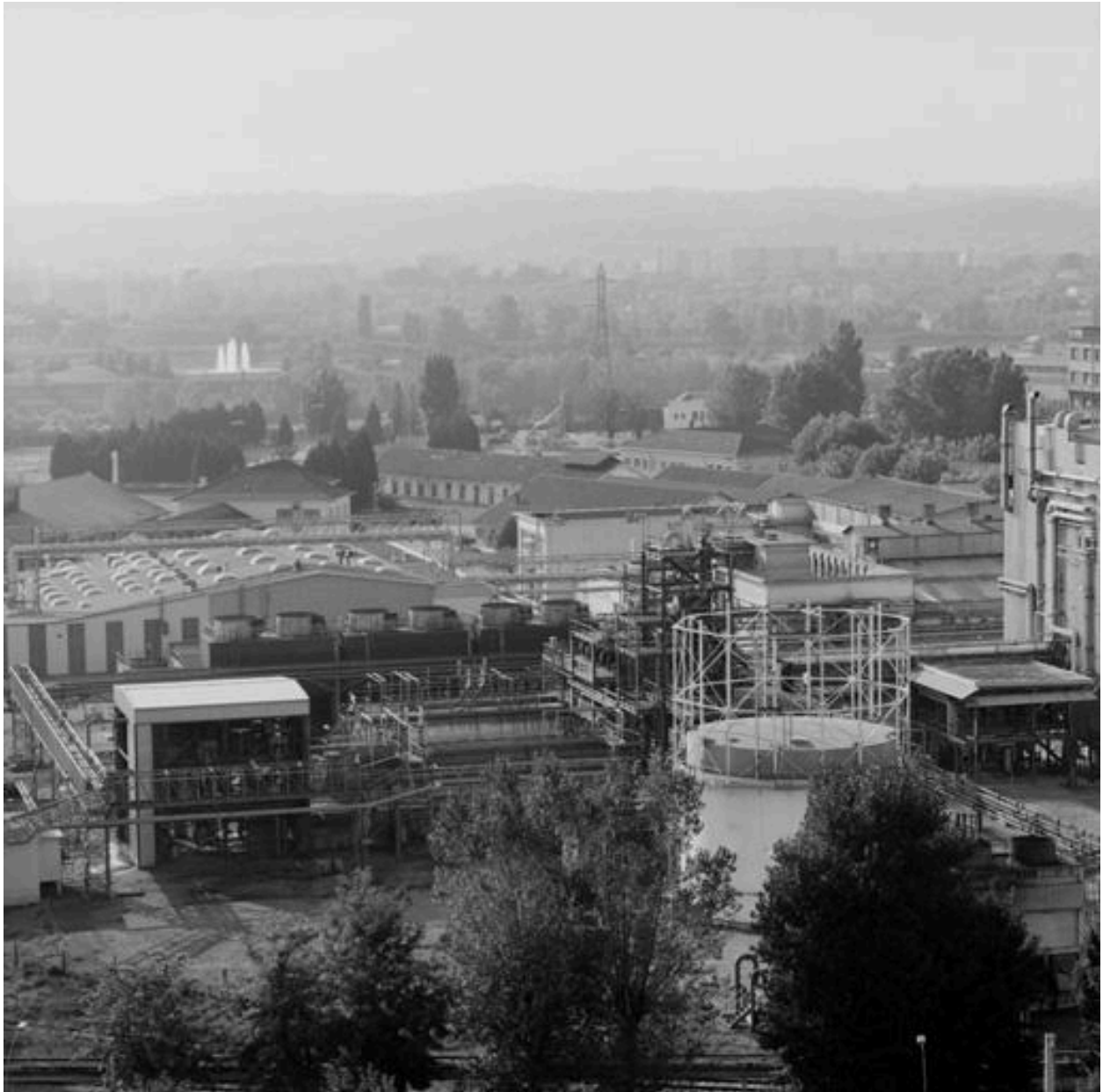
Vue d'ensemble est
