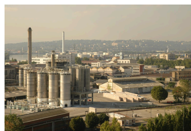
Éléments de production Phot. Nadine Halitim-Dubois IVR82_20066900350NUCA
