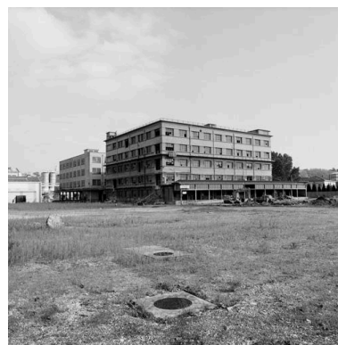
Bâtiment avant démolition Phot. Didier Gourbin IVR82_20056902936X
