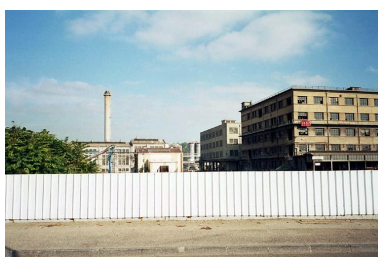
Vue ouest Phot. Nadine Halitim-Dubois IVR82_20066900341NUCA
