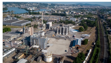
Vue générale de la vallée de la chimie (anciennes usines CIBA et Rhône-Poulenc) Phot. Michel Pérès IVR84_20226900910NUCA
