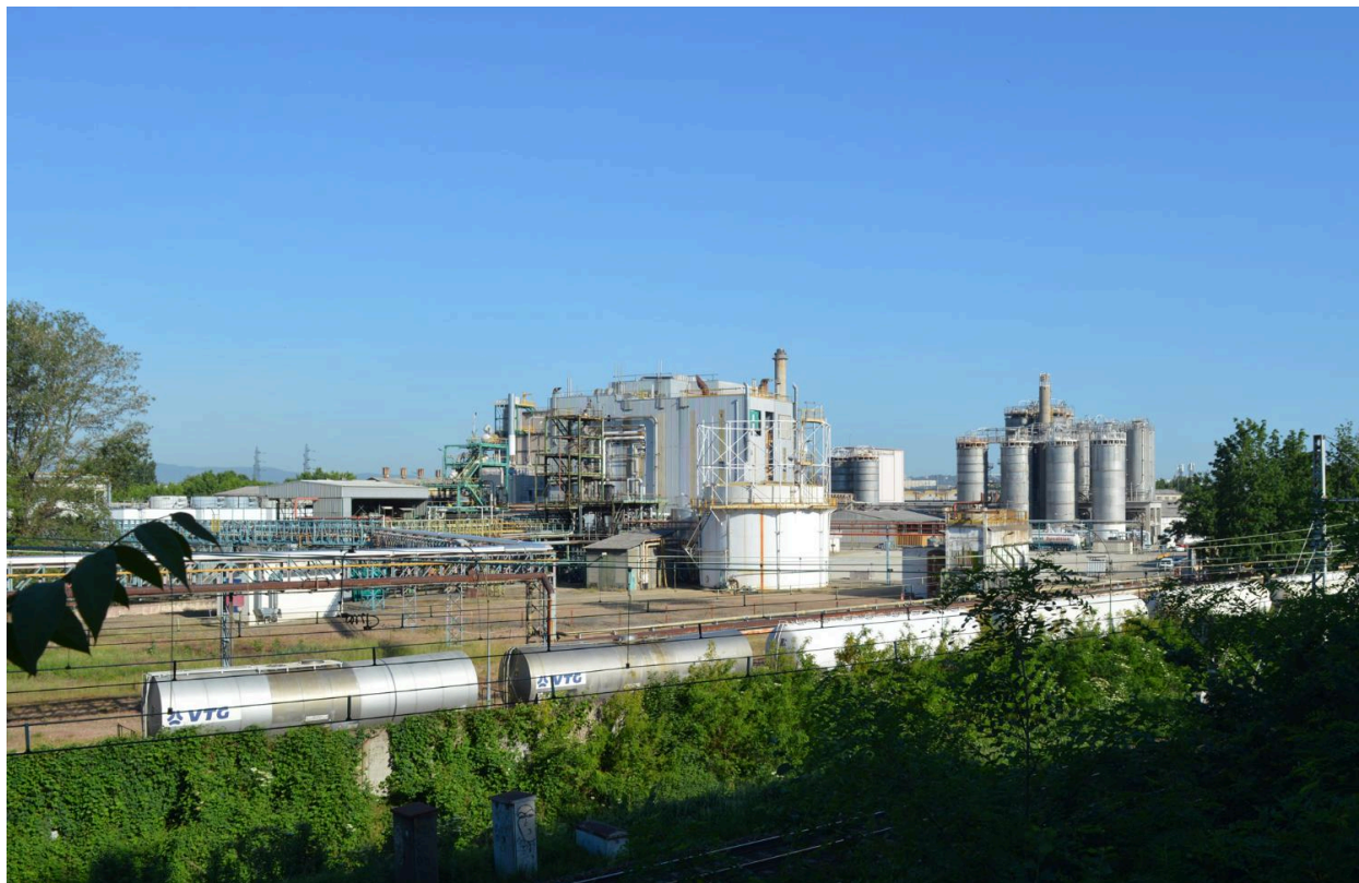
Vue est du site côté voie ferrée
