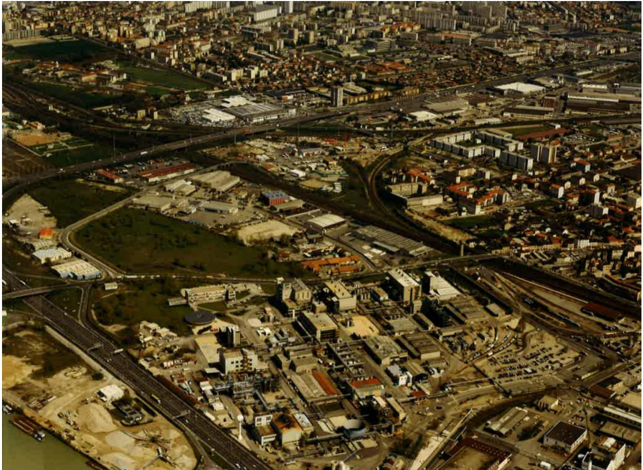
Usine Elf Atochem en 1992, vue aérienne (©Métropole de Lyon : 7152WM 506)
