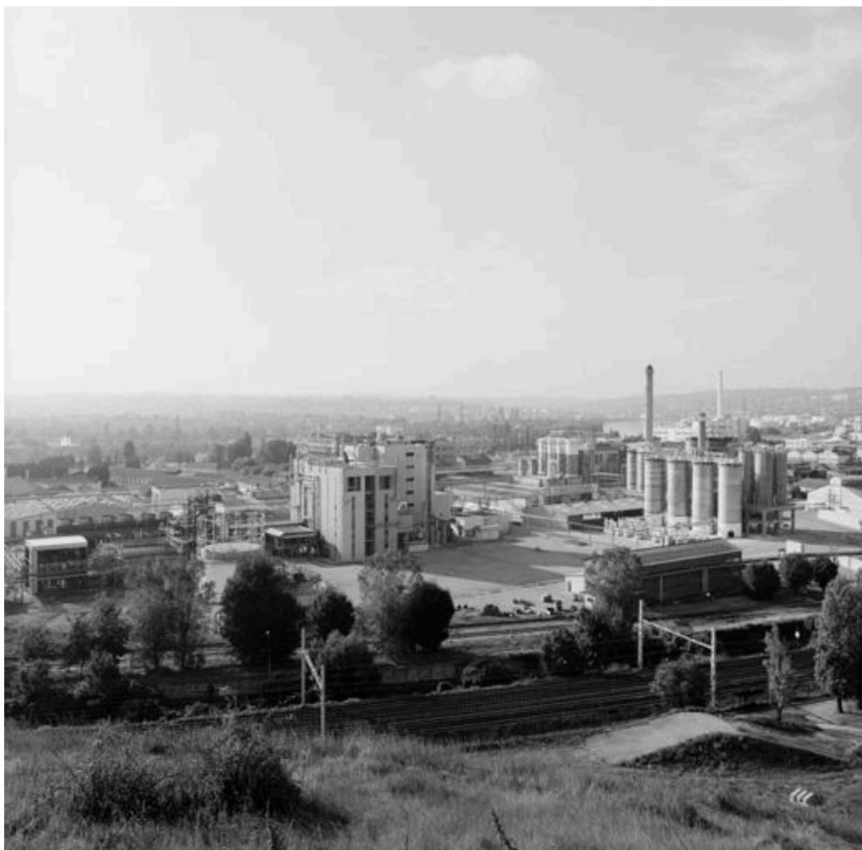
Vue d'ensemble des installations
