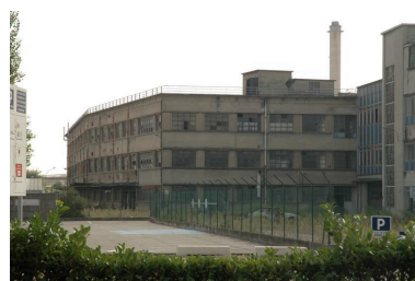
Bâtiment avant démolition Phot. Nadine Halitim-Dubois IVR82_20066900343NUCA
