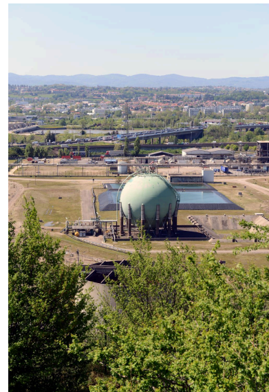
Réservoir sphérique et bassins de rétention, Saint-Fons, 2016 (©Métropole de Lyon) Phot. Emma Arbogast IVR84_20256900839NUCA
