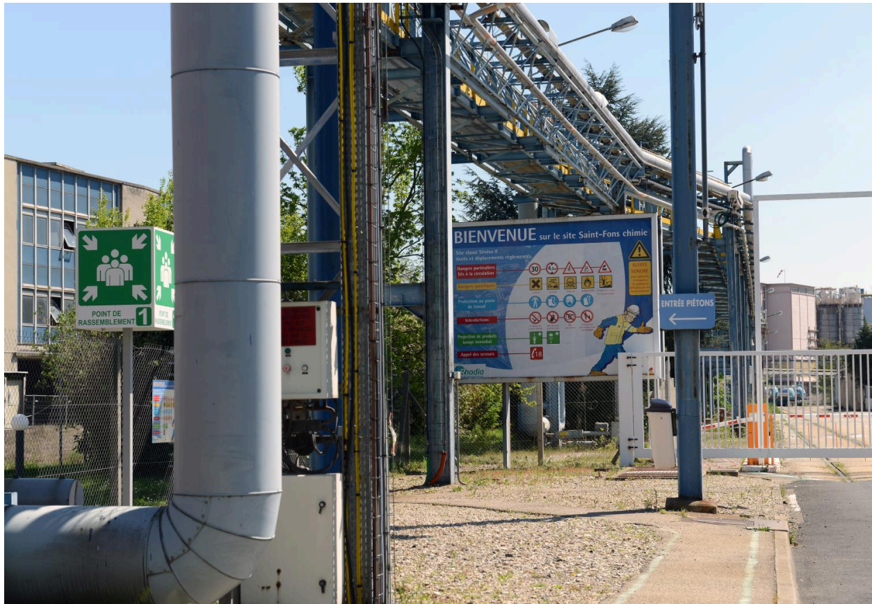
Usine Rhodia, Saint-Fons, 2016 (©Métropole de Lyon)
