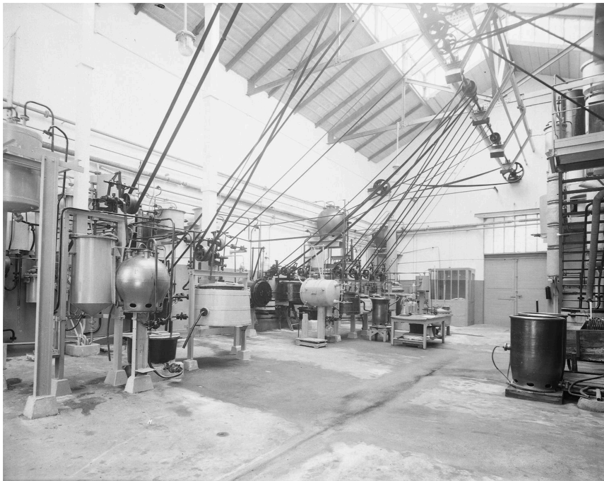
Vue d'intérieur, usine Rhône-Poulenc, 1930 (©BML : P0546 S 1124)
