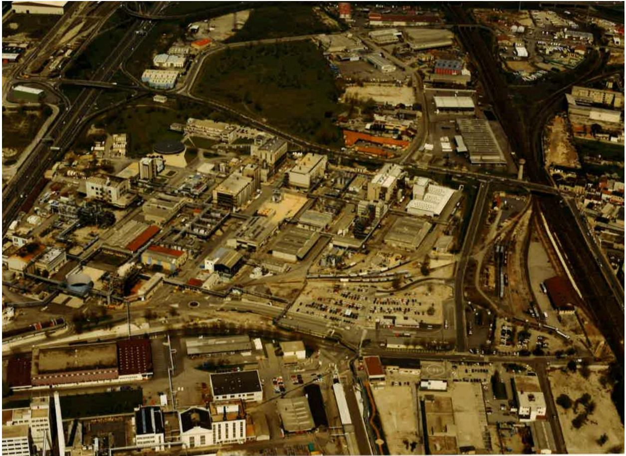
Usine Elf Atochem à Saint-Fons en 1992, vue aérienne (©Métropole de Lyon : 7152WM 506)
