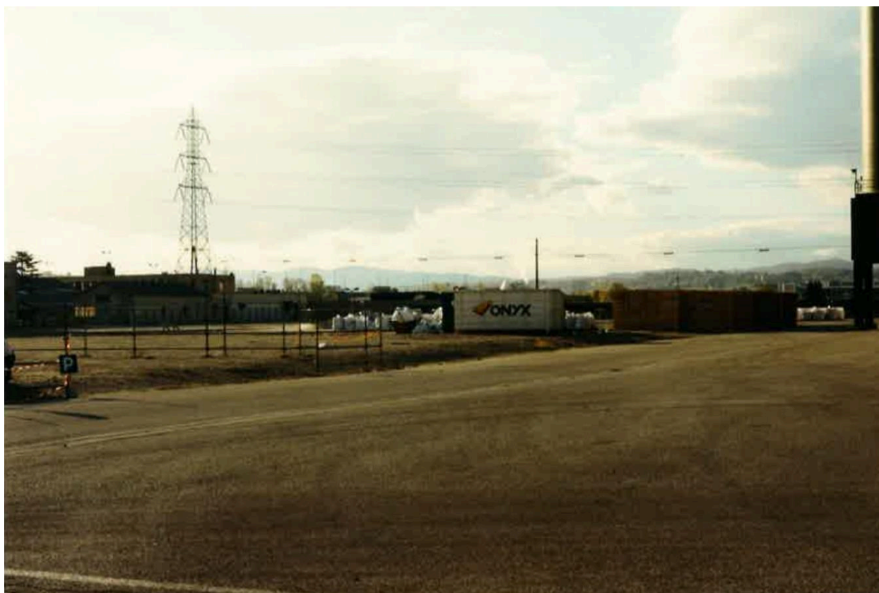
Usine Elf Atochem à Saint-Fons en 1996 (©Métropole de Lyon : 7152WM 511)
