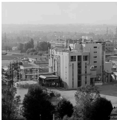
Vue des installations Phot. Didier Gourbin IVR82_20056902939X
