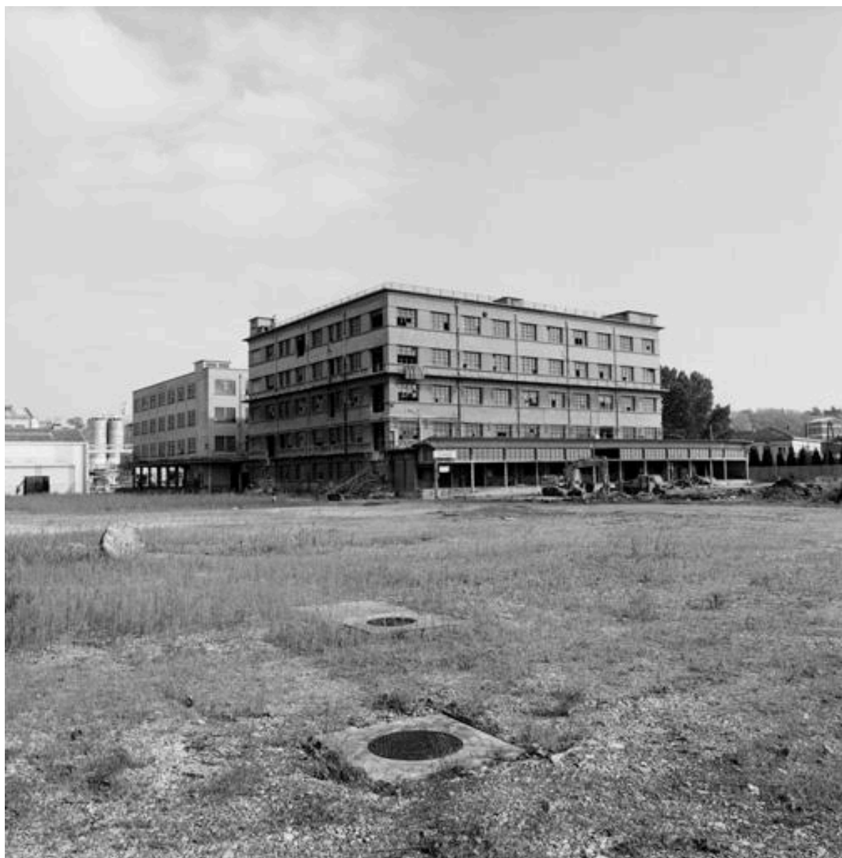
Bâtiment avant démolition
