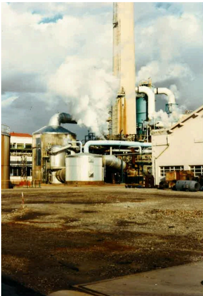
Usine Elf Atochem à Saint-Fons en 1996 (©Métropole de Lyon : 7152WM 509)
