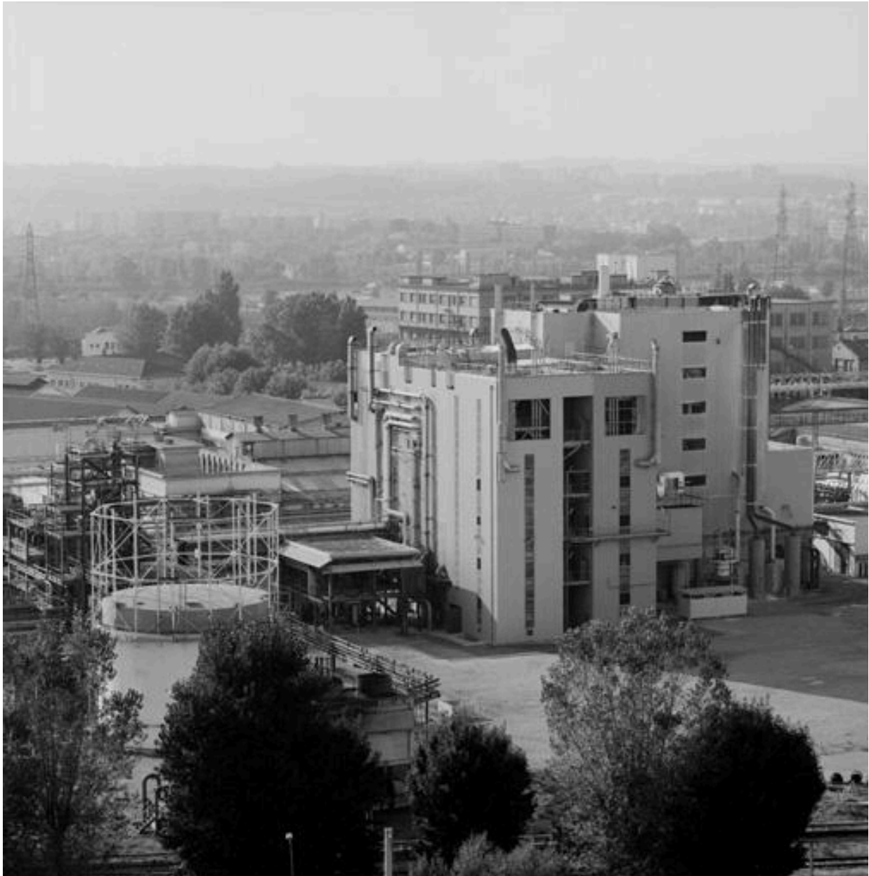
Vue des installations
