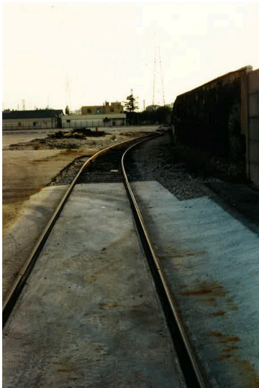
Usine Elf Atochem à Saint-Fons en 1996 (©Métropole de Lyon : 7152WM 511)
