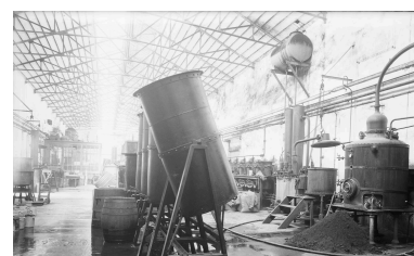
Vue d'intérieur, usine Rhône-Poulenc, 1910 (©BML : P0546 S 1692) Phot. Jules Sylvestre IVR84_20256900083NUC
