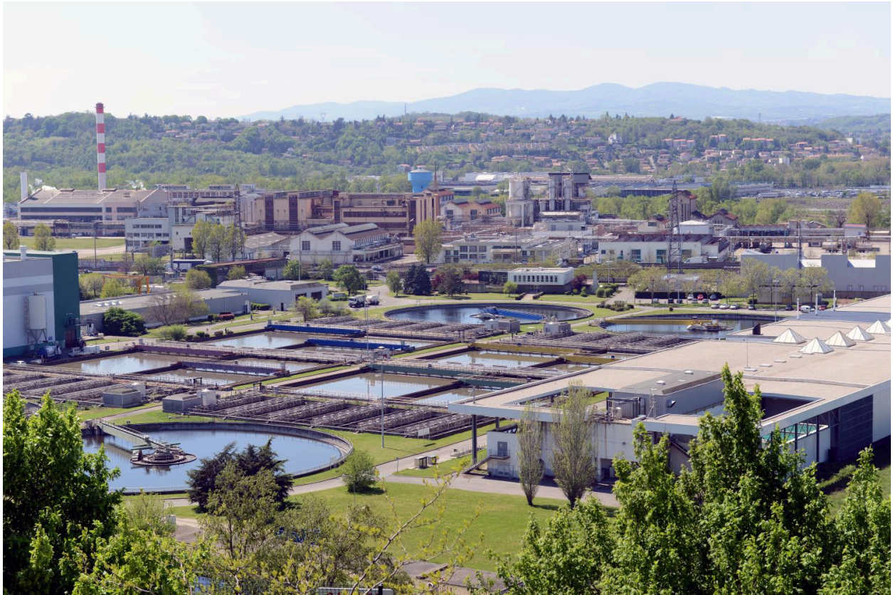
Station d'épuration de Saint-Fons, 2016 (©Métropole de Lyon)
