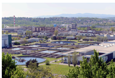
Station d'épuration de Saint-Fons, 2016 (©Métropole de Lyon) Phot. Emma Arbogast IVR84_20256900840NUCA
