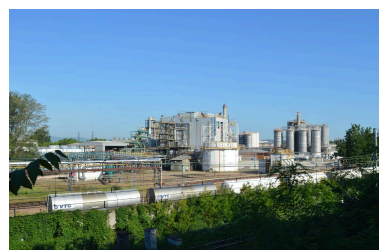
Vue est du site côté voie ferrée Phot. Nadine Halitim-Dubois IVR84_20236900012NUCA
