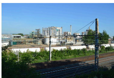
Vue côté raccordement ferroviaire Phot. Nadine Halitim-Dubois IVR84_20236900014NUCA
