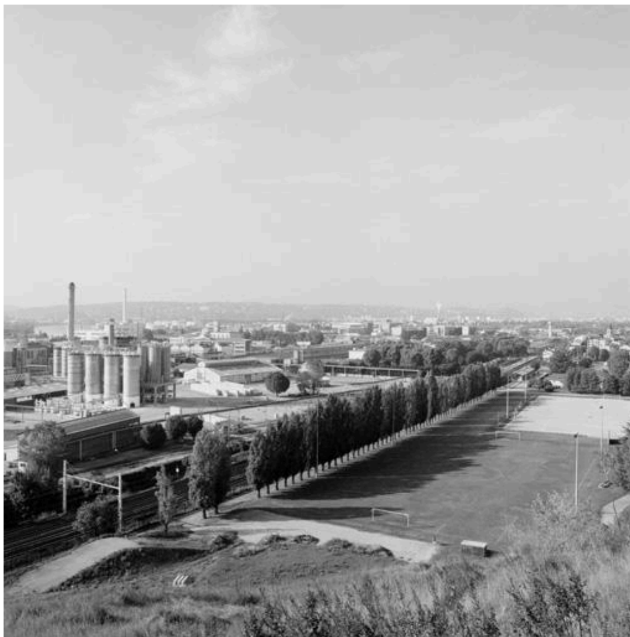
Vue d'ensemble des installations
