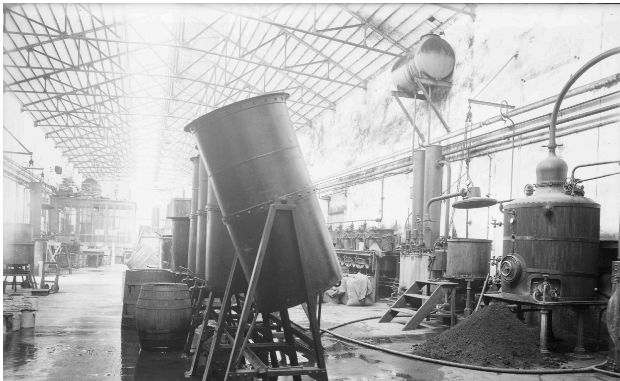
Vue d'intérieur, usine Rhône-Poulenc, 1910 (©BML : P0546 S 1692)
