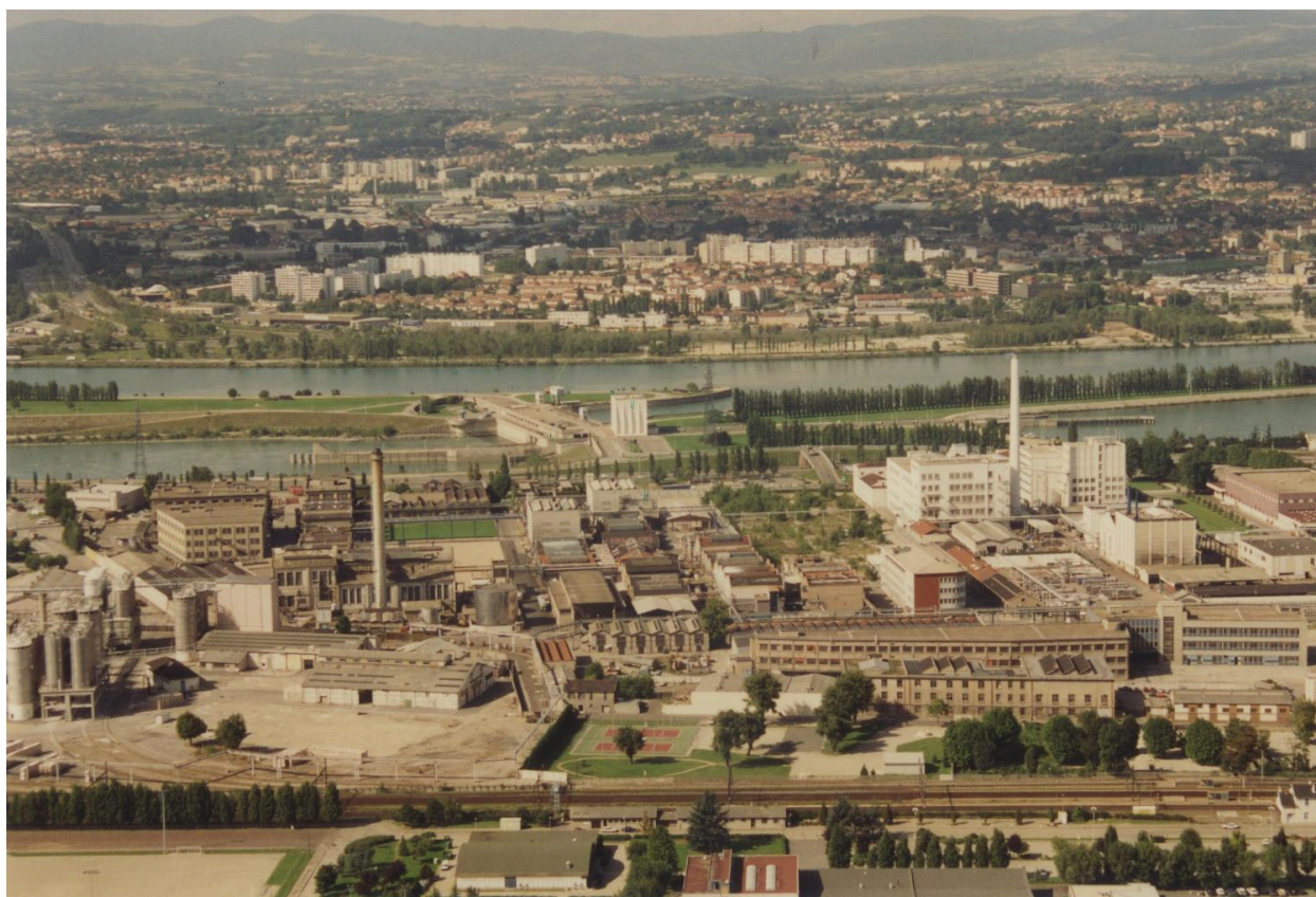
Vue sur les bâtiments Rhône-Poulenc dans la zone industrielle, Saint-Fons, 1992 (©Métropole de Lyon)
