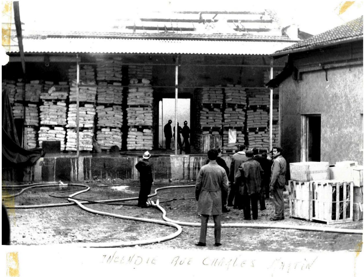
Incendie des usines Rhône-Poulenc, s.d , Saint-Fons (©AC Saint-Fons)
