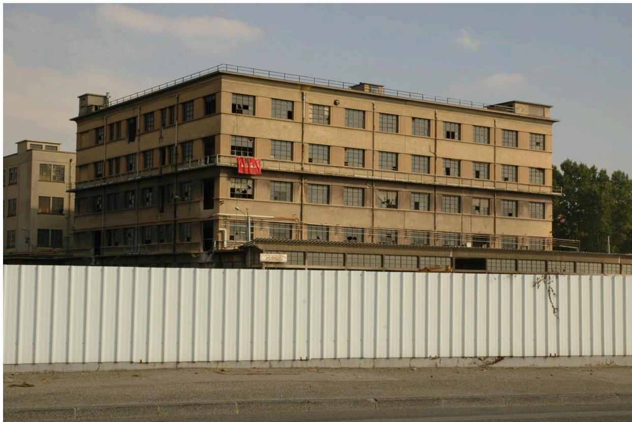
Détail bâtiment avant démolition
