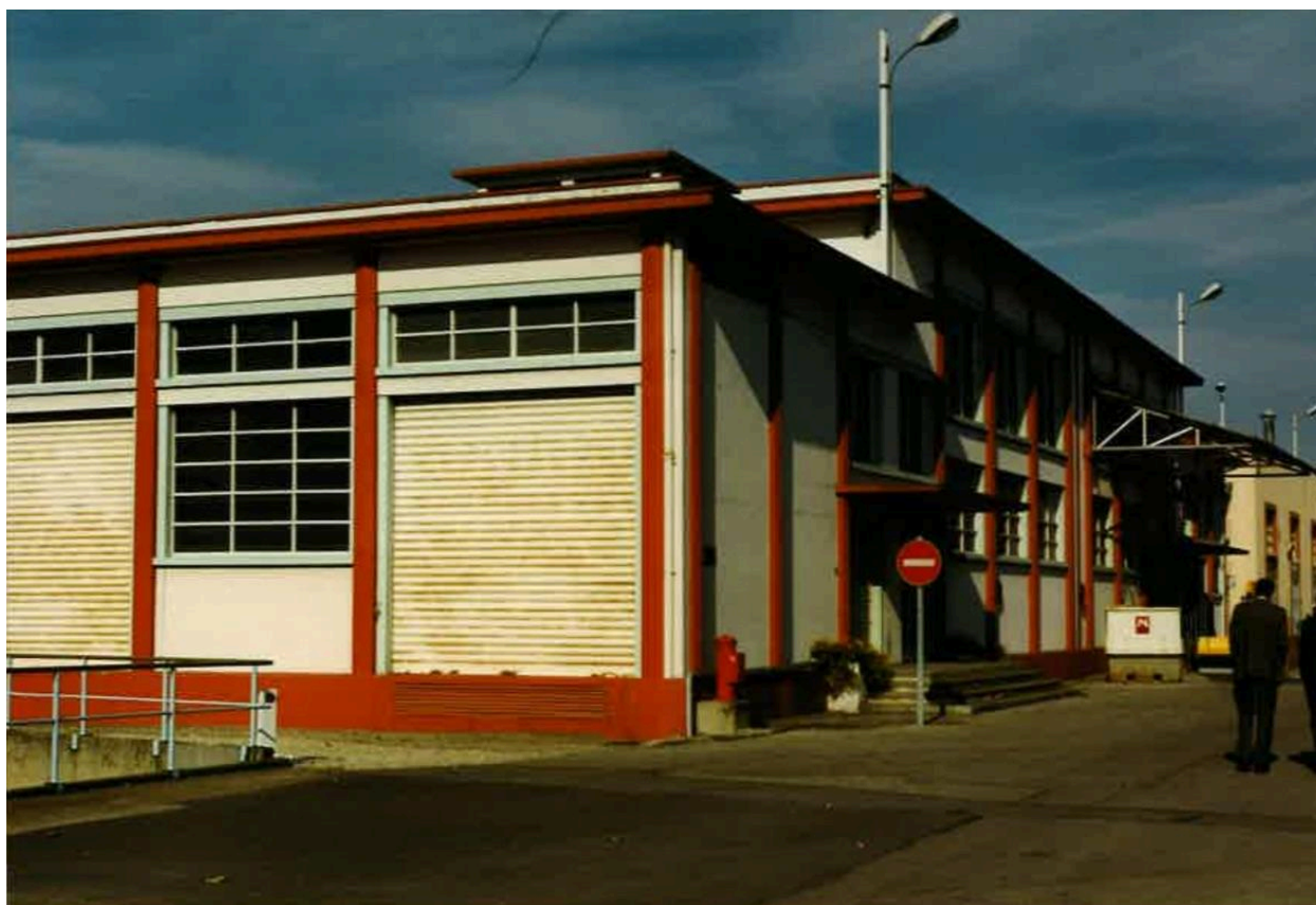
Usine Elf Atochem à Saint-Fons en 1996 (©Métropole de Lyon : 7152WM 509)
