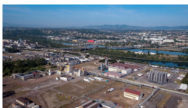
Vue générale de la vallée de la chimie (anciennes usines St-Gobain, Pechiney St- Gobain puis Rhône-Poulenc) Phot. Michel Pérès IVR84_20226900913NUCA
