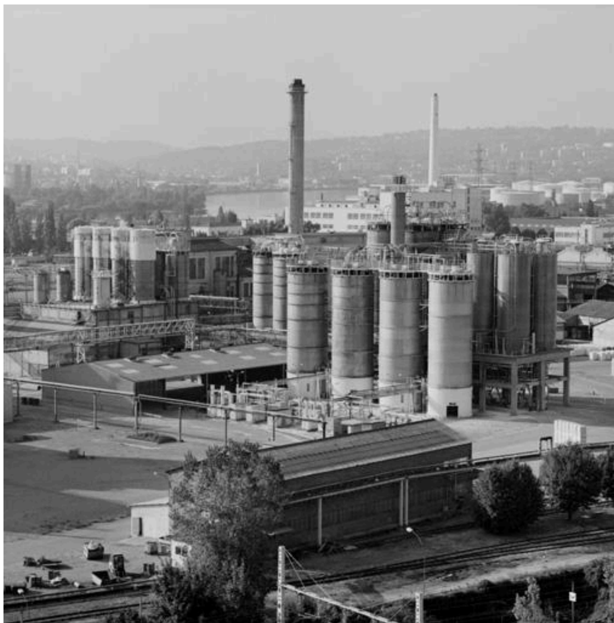
Détail installations de production
