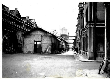
Usines Rhône-Poulenc, bâtiment laboratoire 1961, Saint-Fons (©AC Saint-Fons) Phot. Léa Mauris-Demourieux IVR84_20256900856NUC
