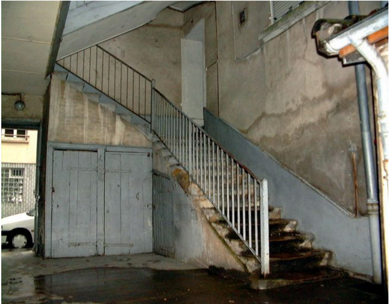
Départ de l'escalier contre la façade sur rue
