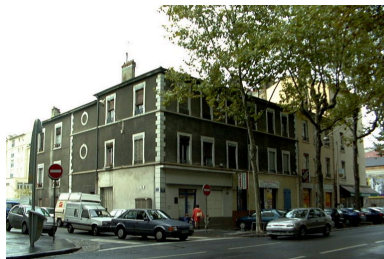
Vue générale depuis le cours Suchet Phot. Bernard Ducouret IVR82_20006900535NUCA
