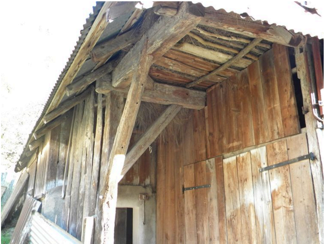
Détail de la charpente.
