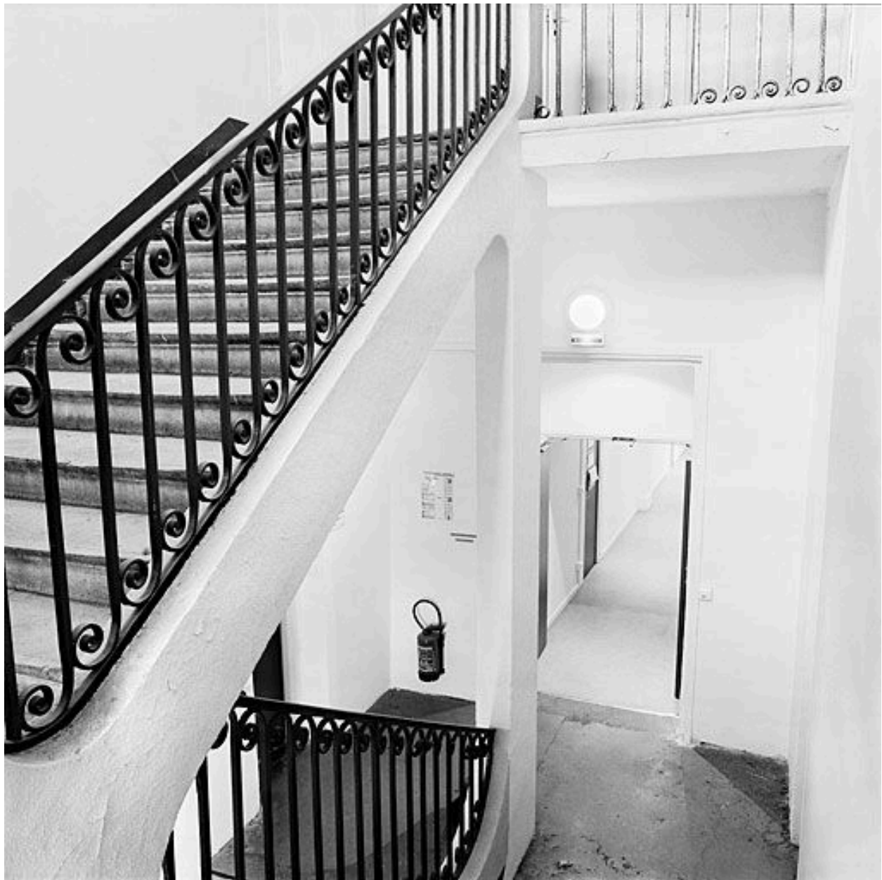
Vue de l'escalier nord au niveau du 1er palier
