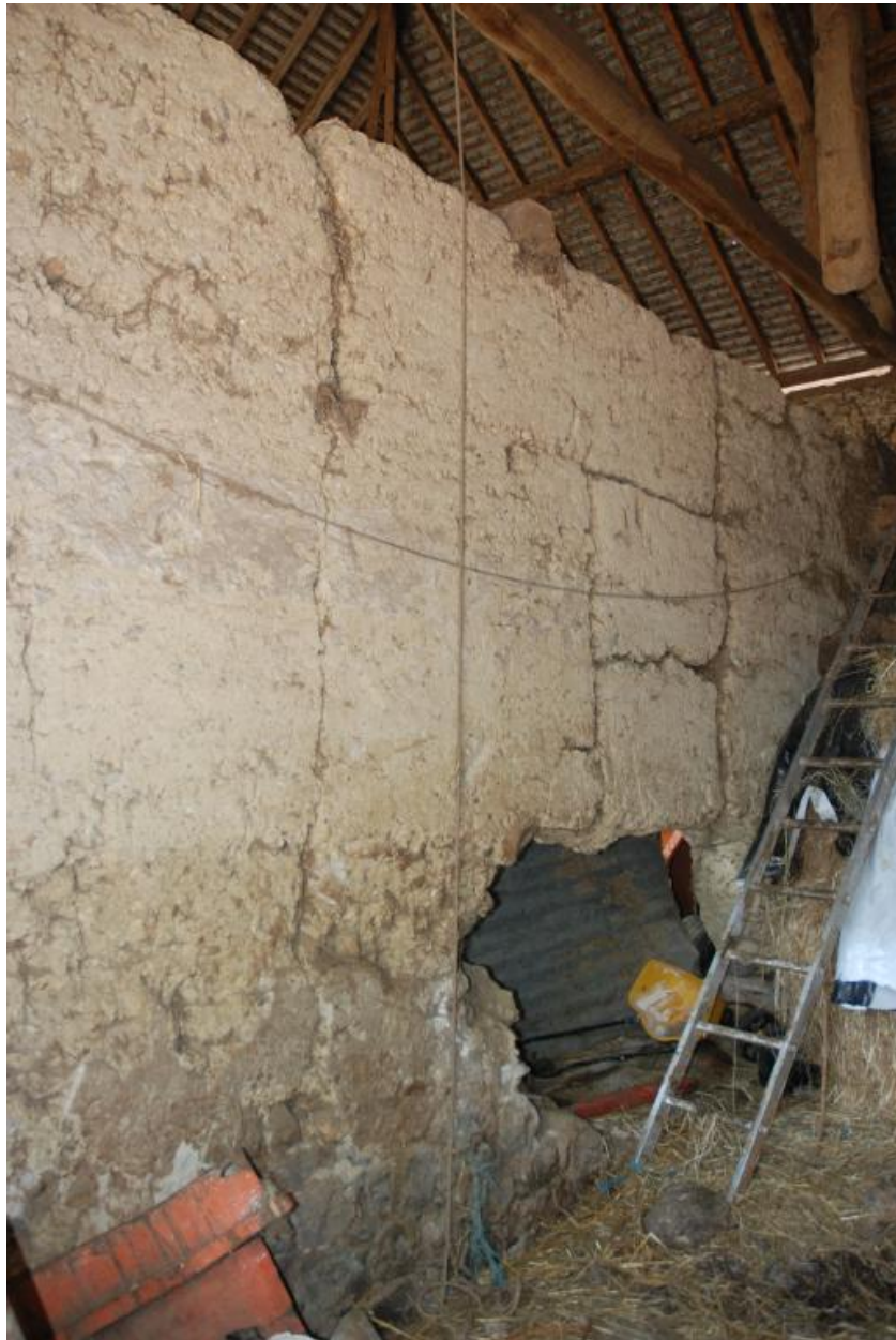
Vue intérieure du mur en pisé séparant la grange et la remise.
