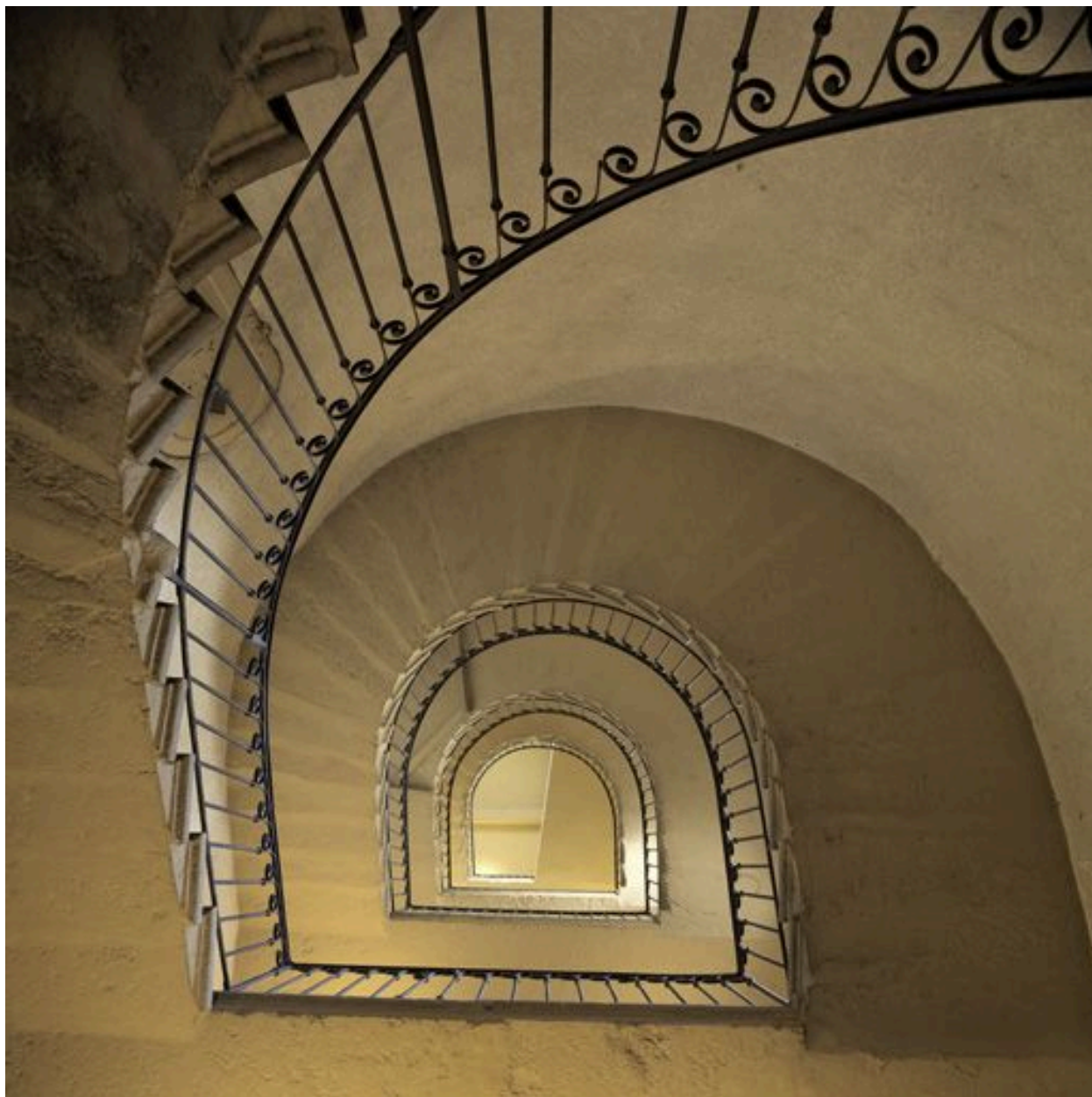
Vue de la cage d'escalier depuis le sol
