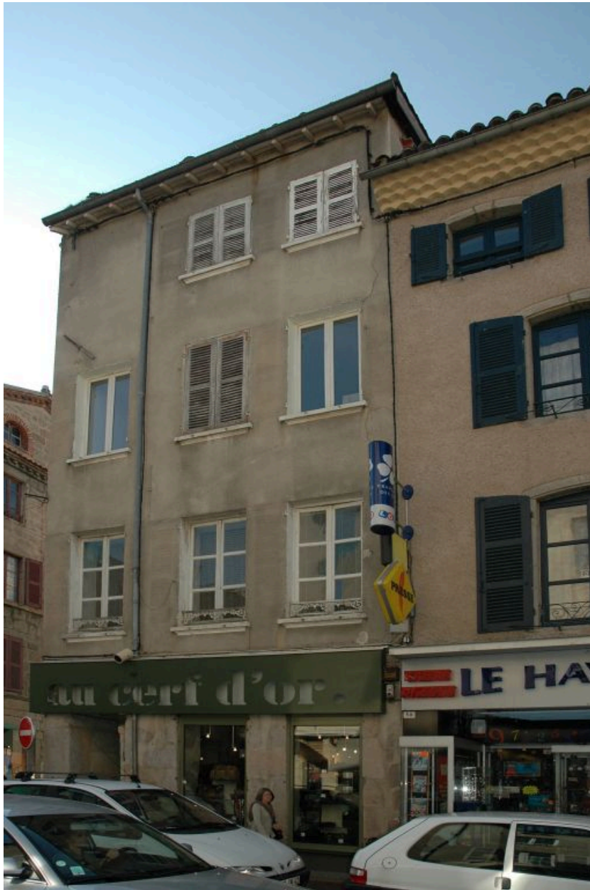
Vue générale sur la rue Tupinerie.
