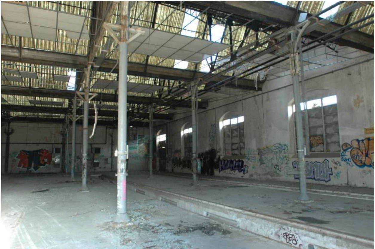
Vue intérieur série de poteau fonte
