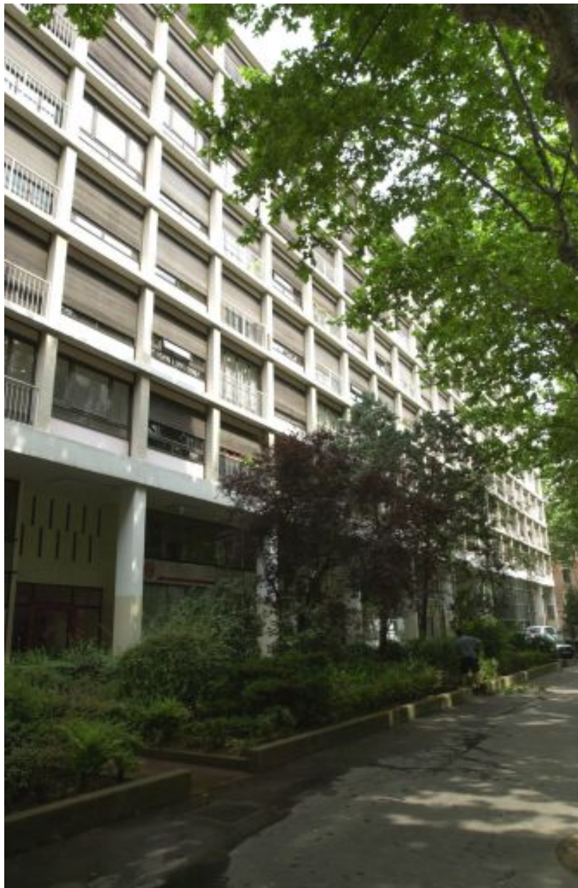
Vue d'ensemble depuis le sud, galeries et jardin
