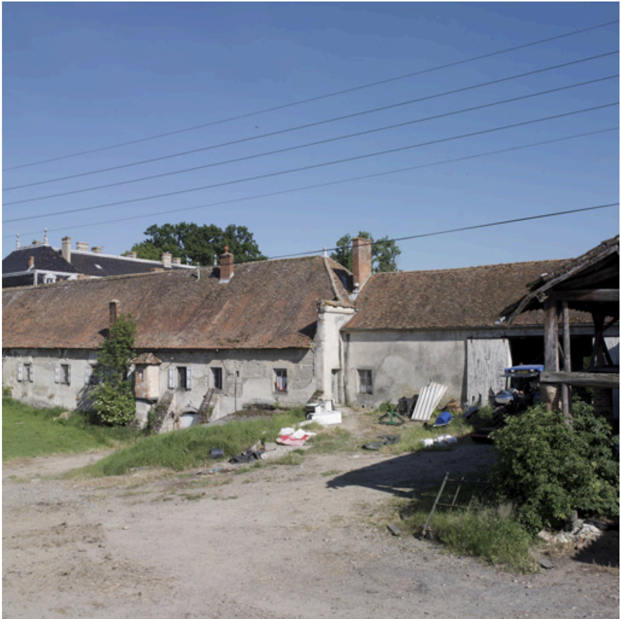
Vue de l'aile nord, partie ouest de l'élévation nord, depuis le nord-ouest.
