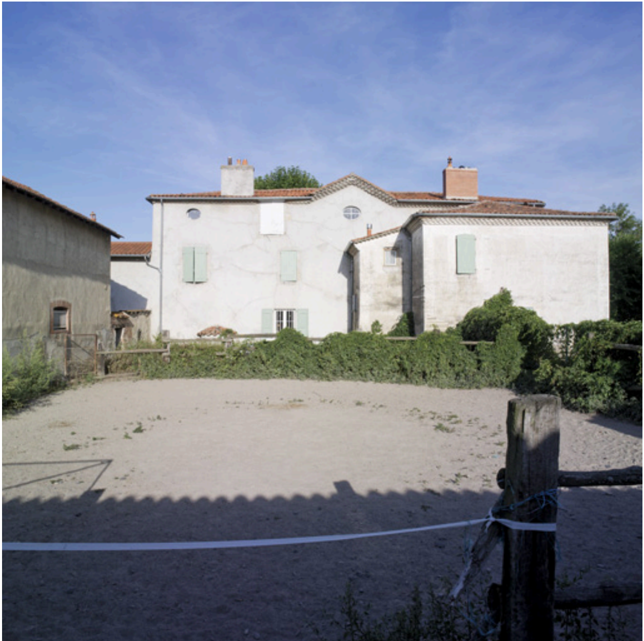
Vue arrière (ouest) de la demeure.
