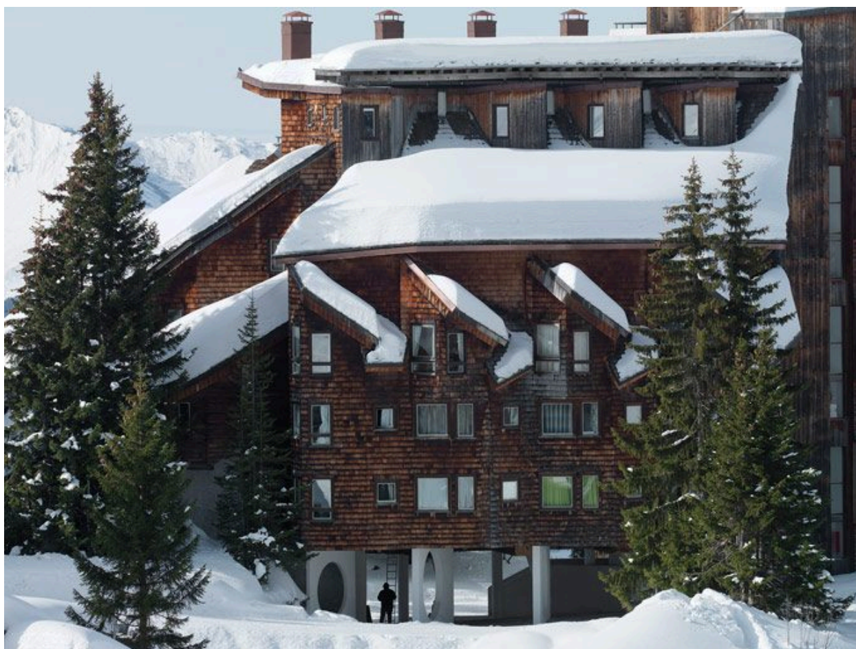
Façade nord. Le passage sous le bâtiment
