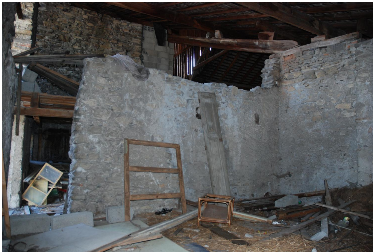
Maison, immeuble, 48 à 58 rue Louis Blanc-Pinget (2018 E1 350). Bâtiment sur cour. Comble.
