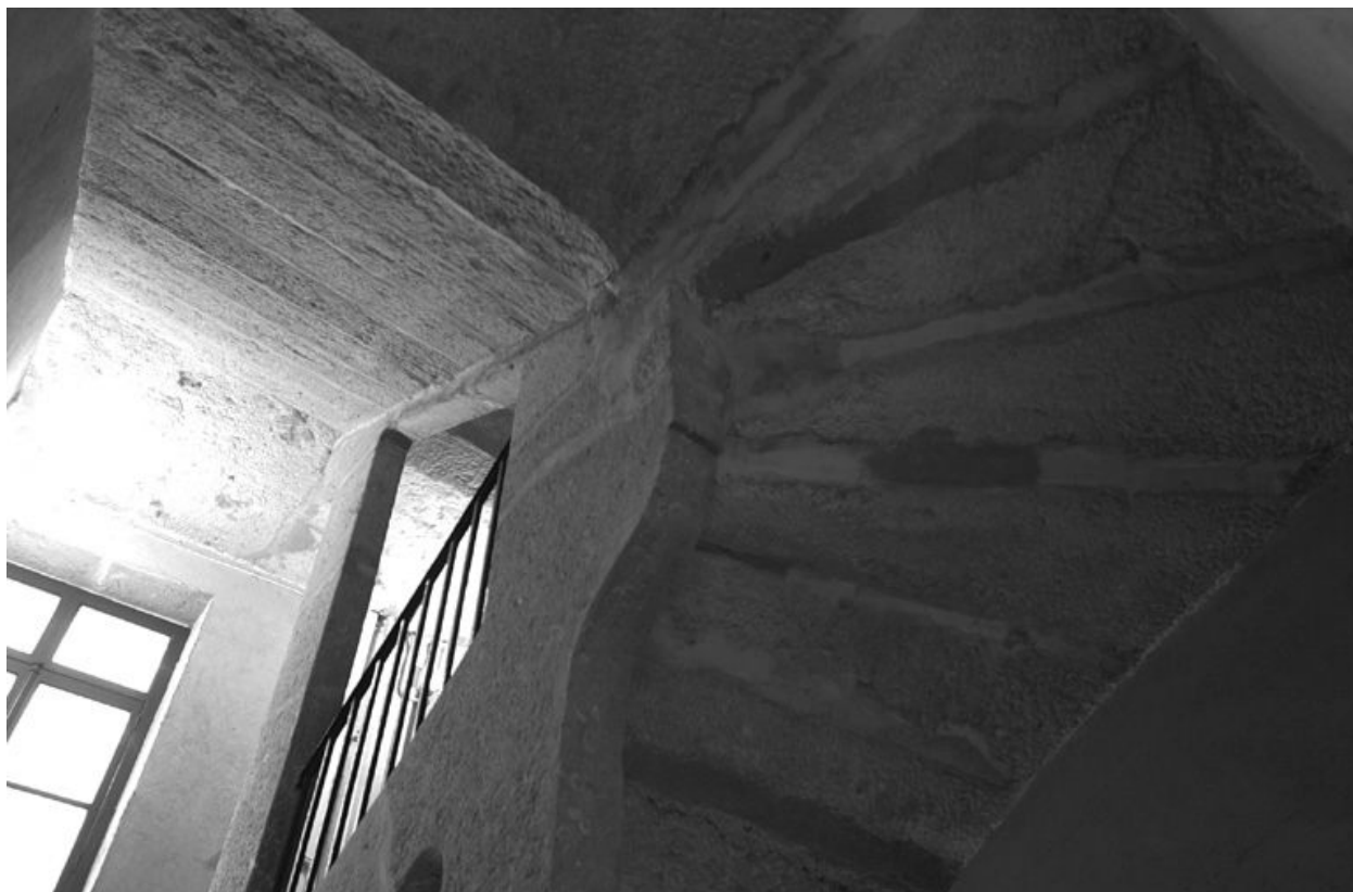
Couvent : 11 place Antonin-Gourju, vue du retour de marches de l'escalier
