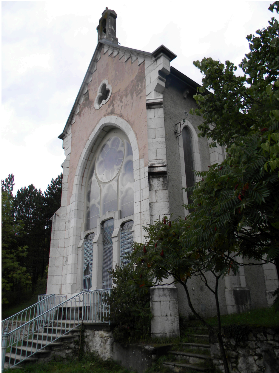
Vue de trois-quarts de la chapelle avec accès à la terrasse est.
