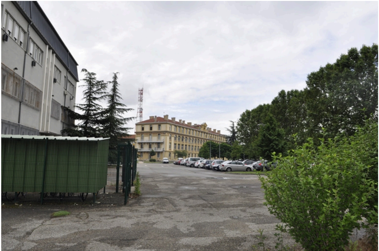
Bâtiment de 1916, façade nord et pignon est.
