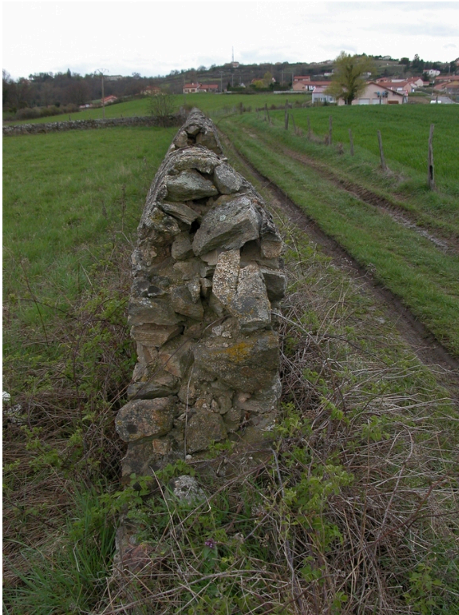
Détail du mur de clôture.
