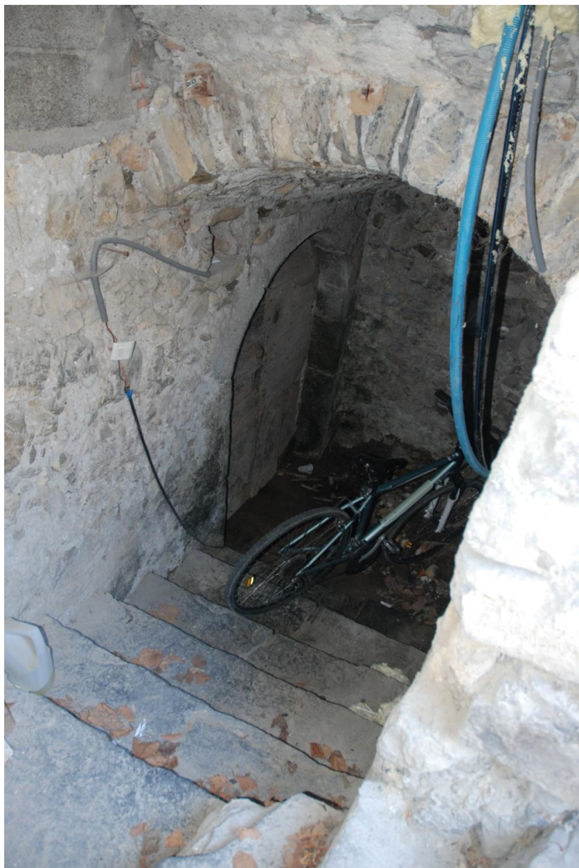
Maison de vigneron (2018 I1 197), détail de l'accès à la cave.
