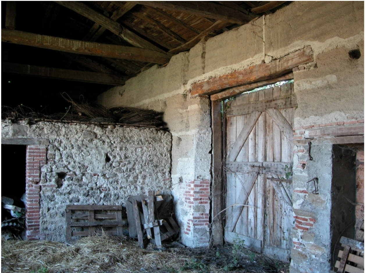
Vue intérieure de la partie grange-remise.
