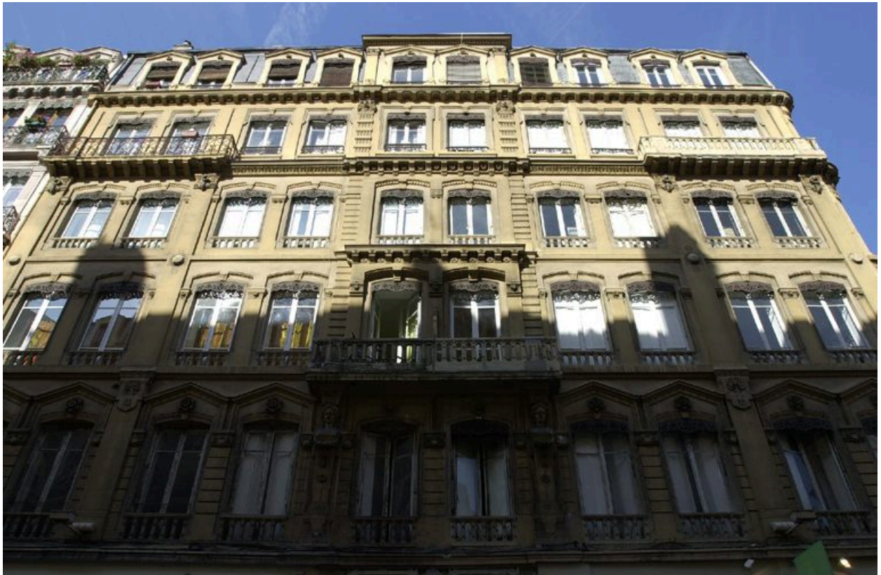
Elévation antérieure : les étages supérieurs
