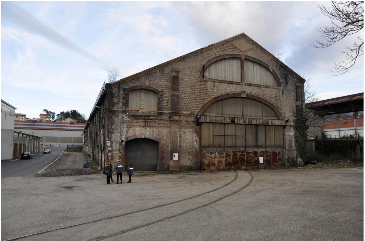
Halle 06 démolie vue extérieure
