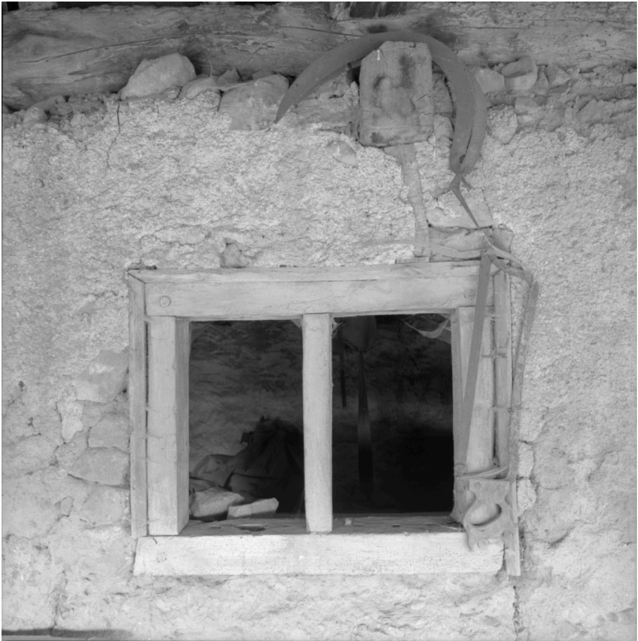
détail de la baie éclairant le 1er étage du logis.
