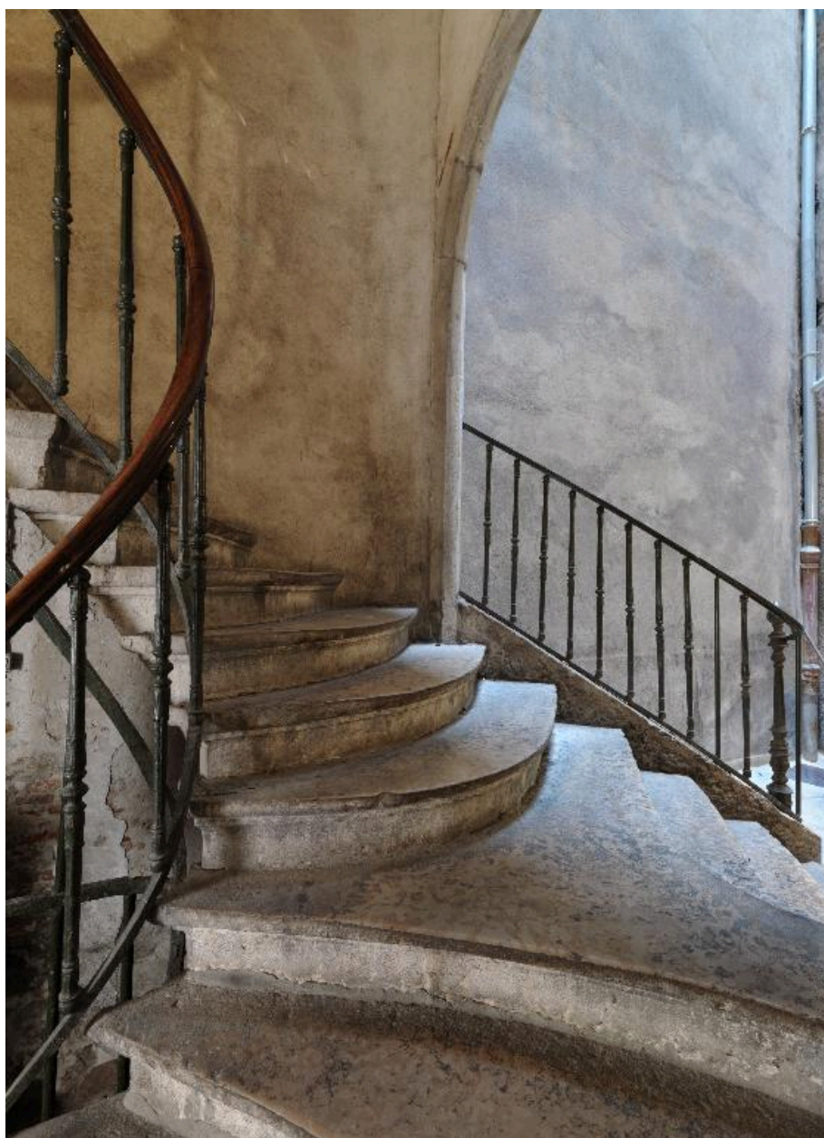
Le double départ de l'escalier, vu depuis l'est
