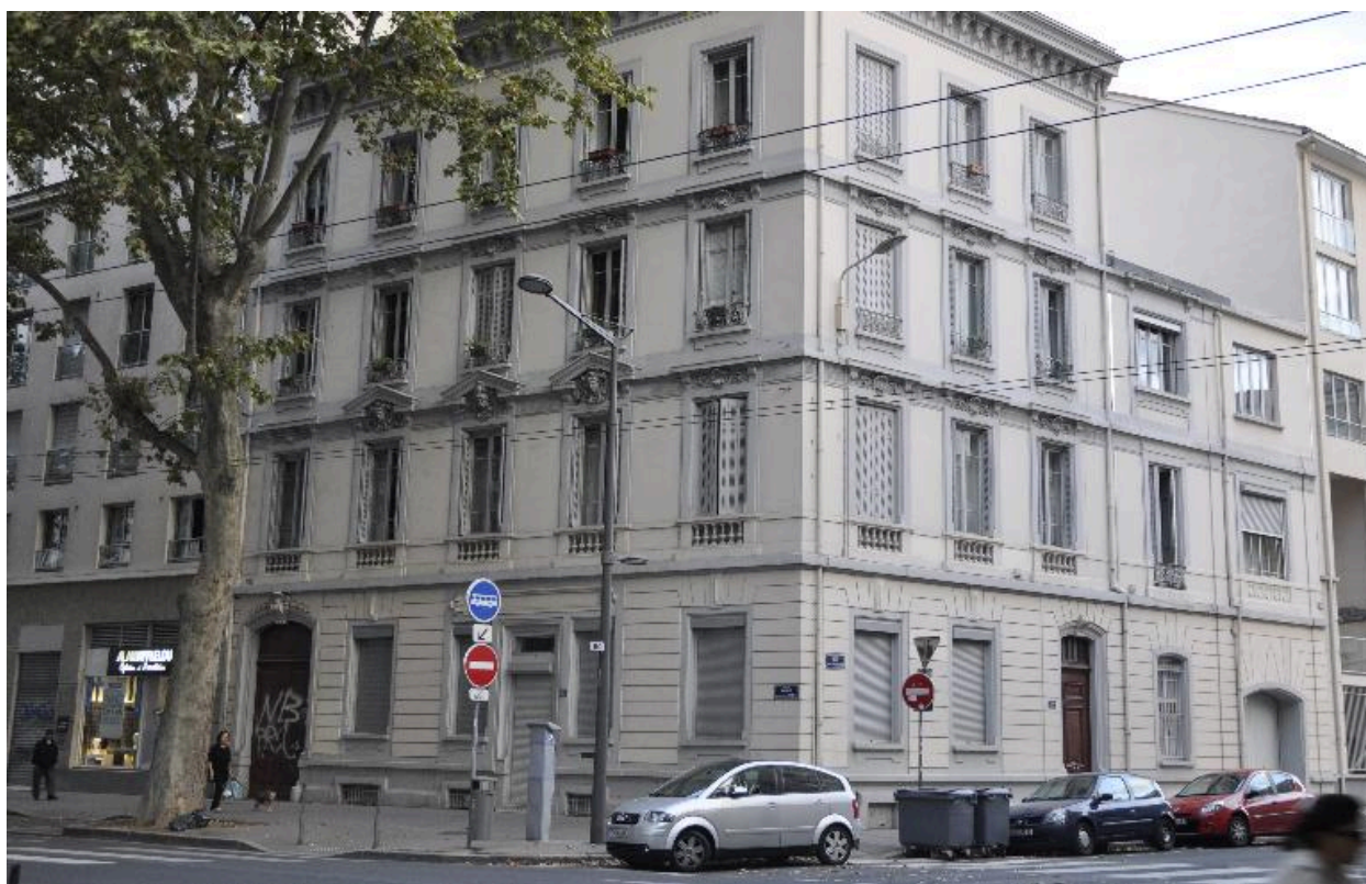
Vue d'ensemble angle rue du père Chevrier
