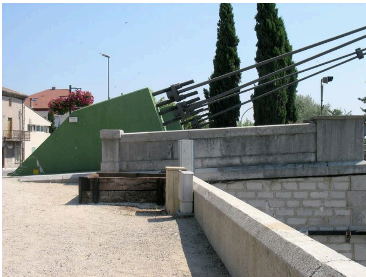
Vue d'un massif d'ancrage du pylône côté La Voulte
