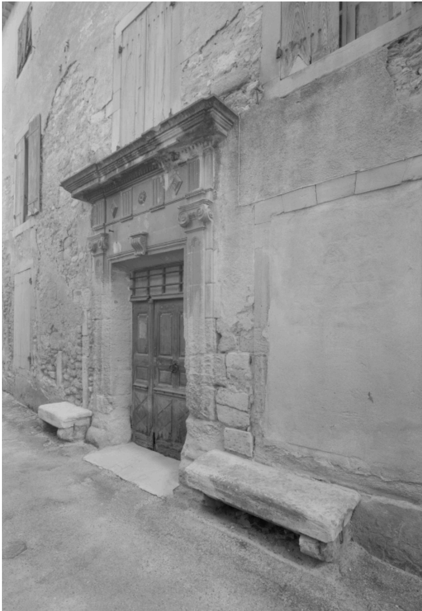
Rue Saint-Louis. Maison (D2 1115) : porte à encadrement architectural de style ionique.
