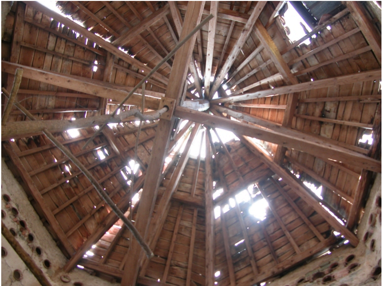
Vue intérieure du pigeonnier : la charpente.
