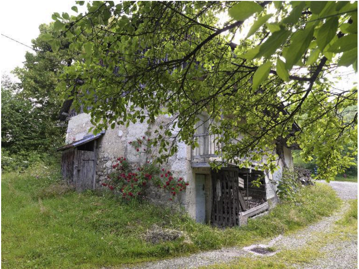
Vue depuis le sud-ouest.
