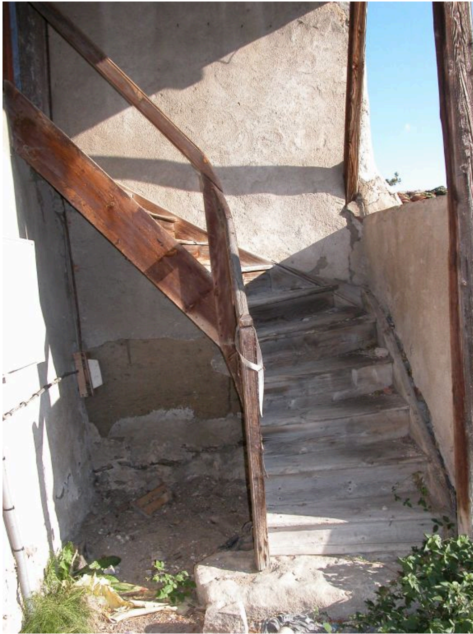
Vue d'ensemble de l'escalier tournant du logis conduisant à l'étage carré.
