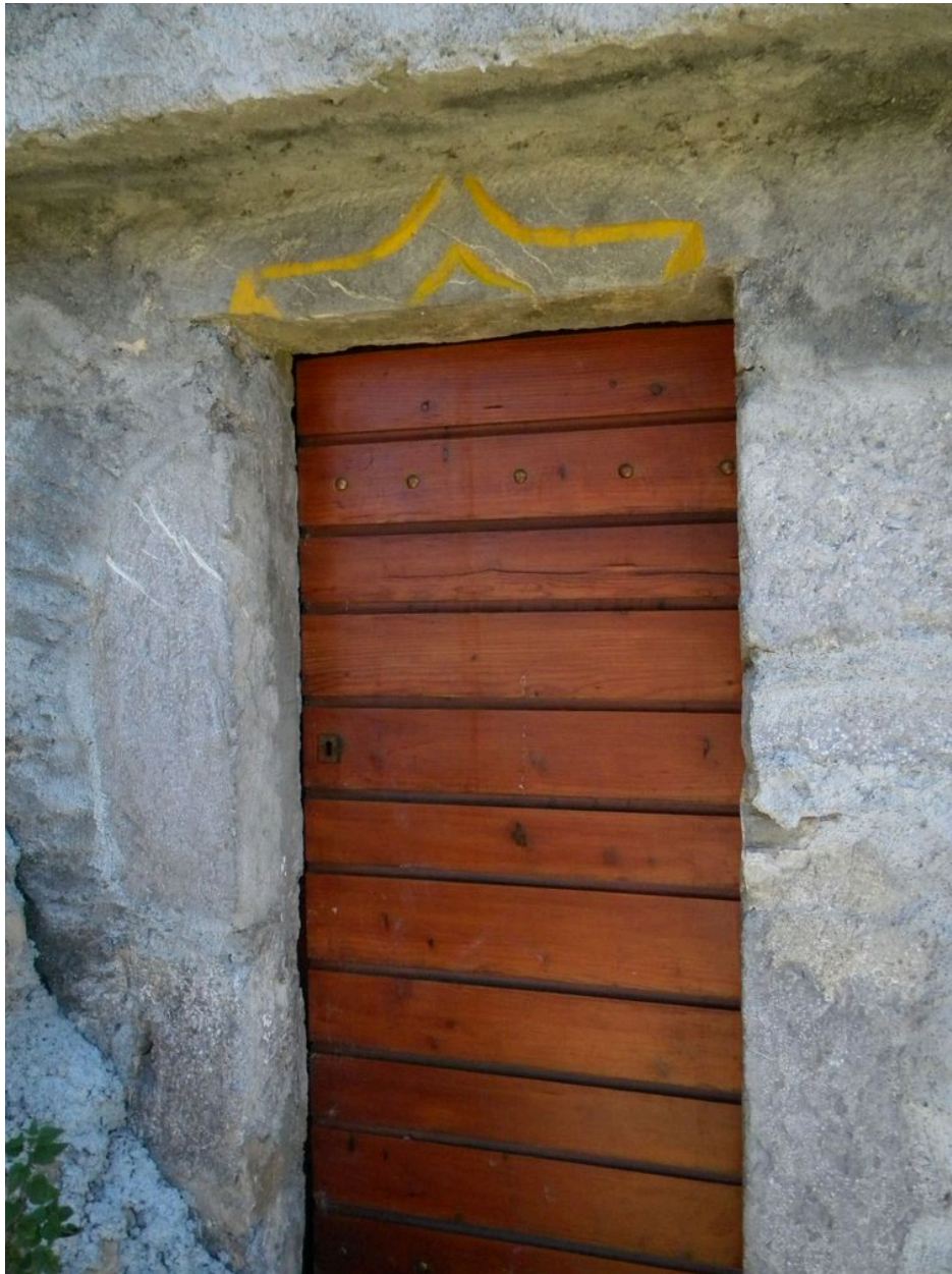
Détail d'une porte à accolade de remploi sur un bâtiment récent.
