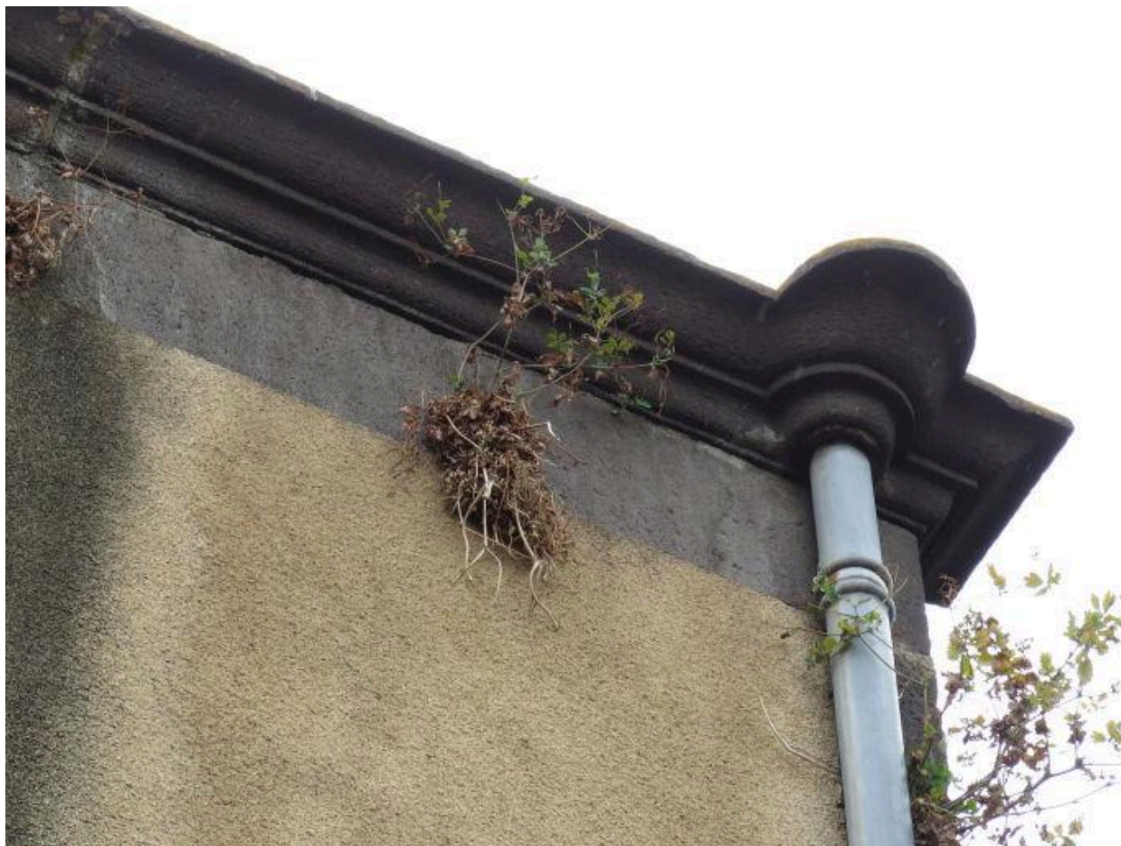
Corniche et cuvette d'évacuation avec moulure supplémentaire : Châteaugay, 38 rue Antoine-Lannes
