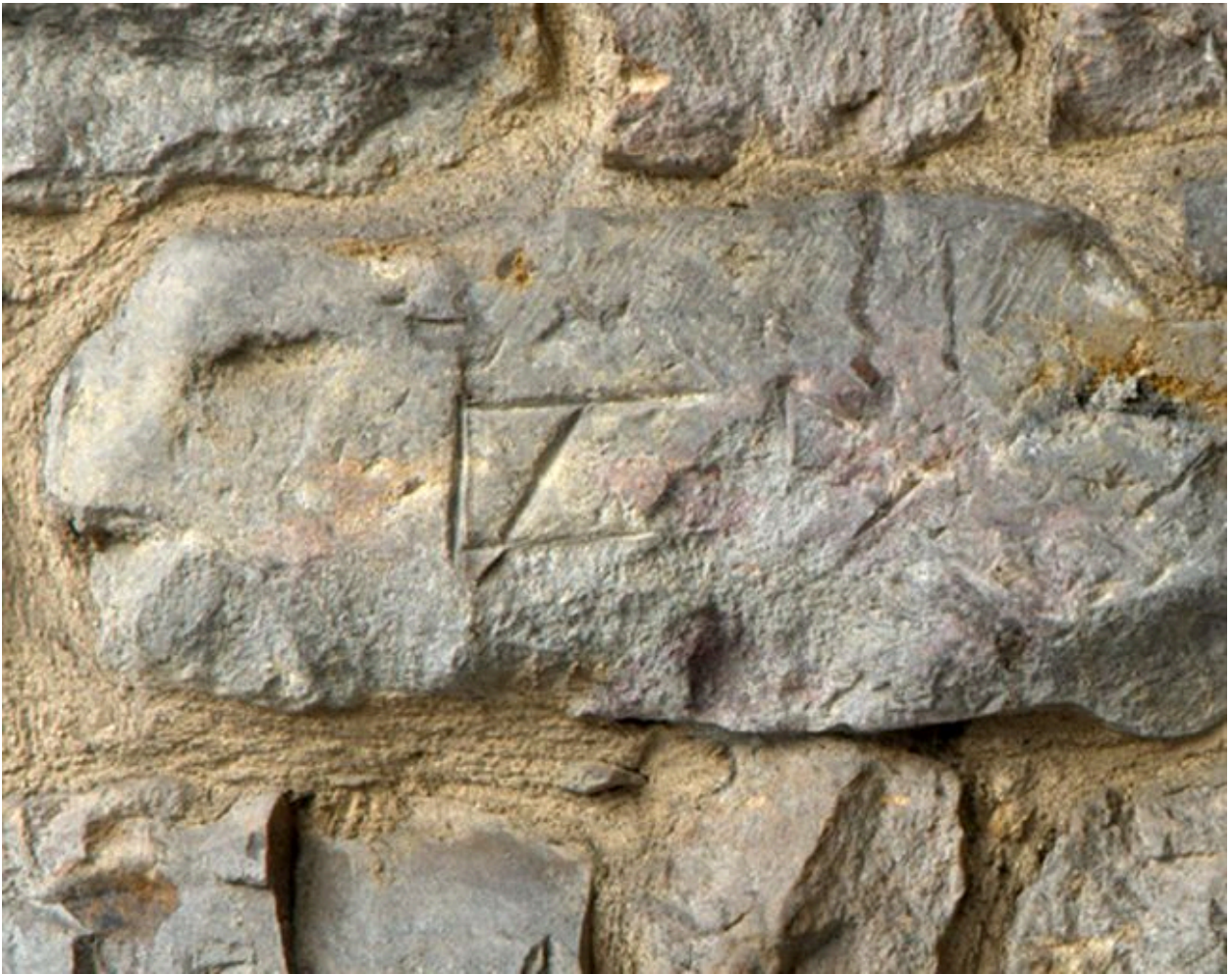
Marque de tâcheron, mur du rez-de-chaussée en revers de façade
