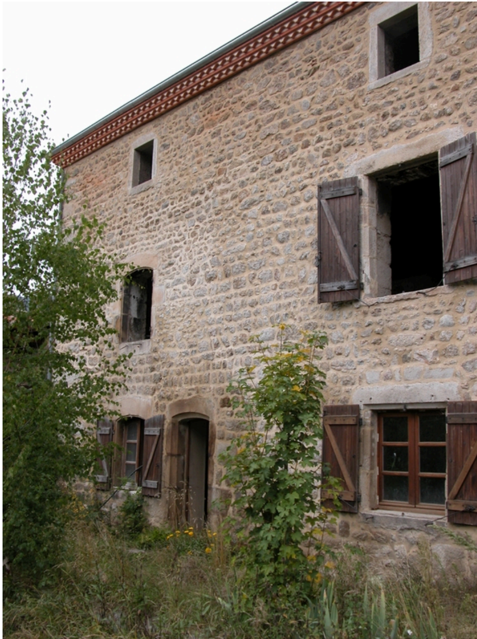
Façade sud, partie ouest.
