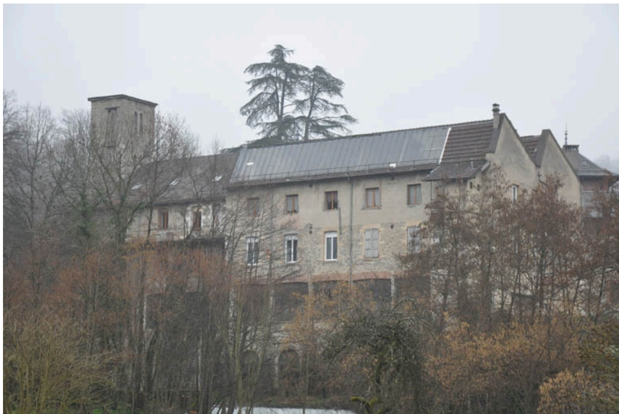
Vue de la façade nord de l'usine
