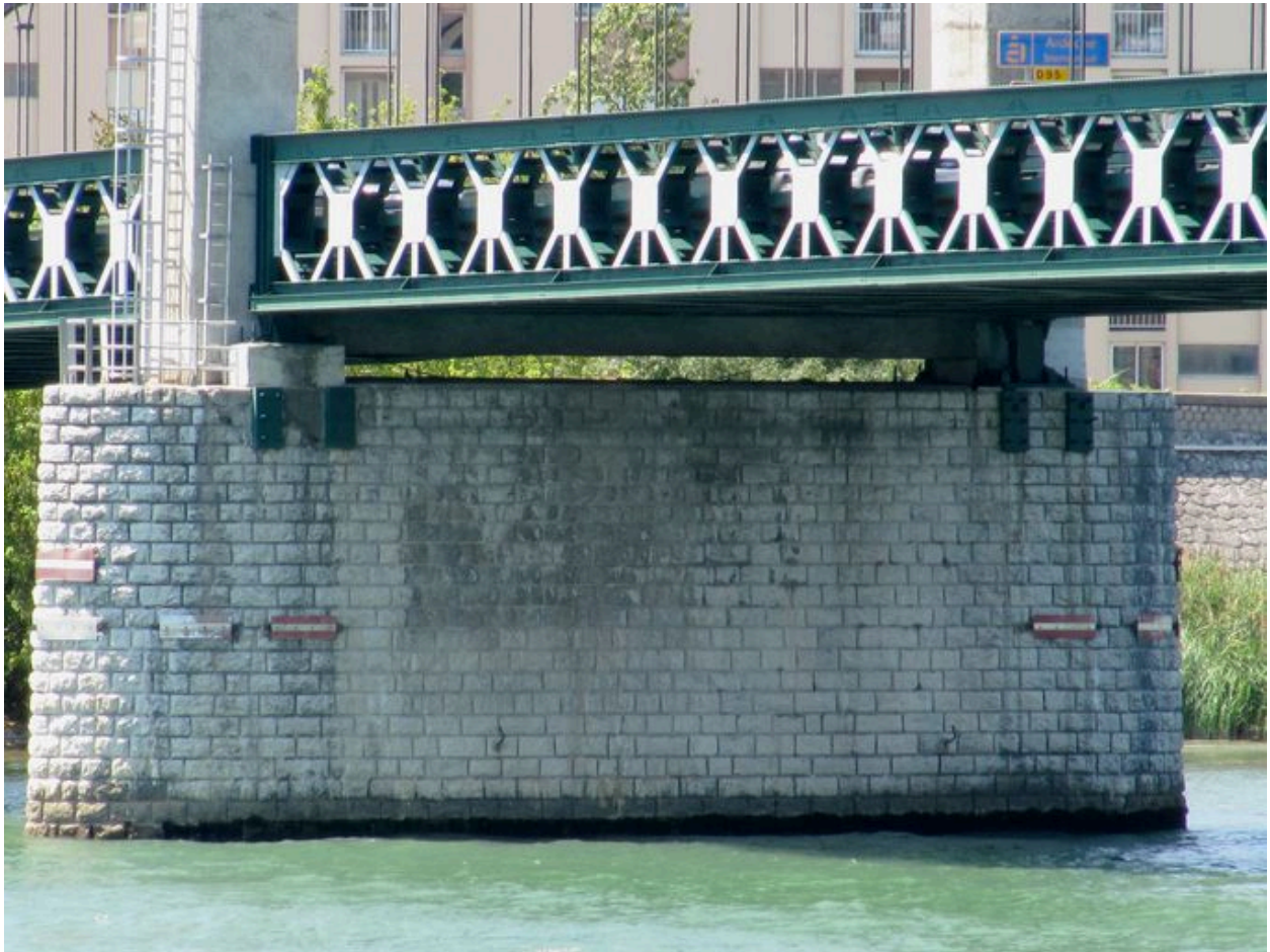
Pylône central, vue partielle : pile (depuis la rive gauche)
