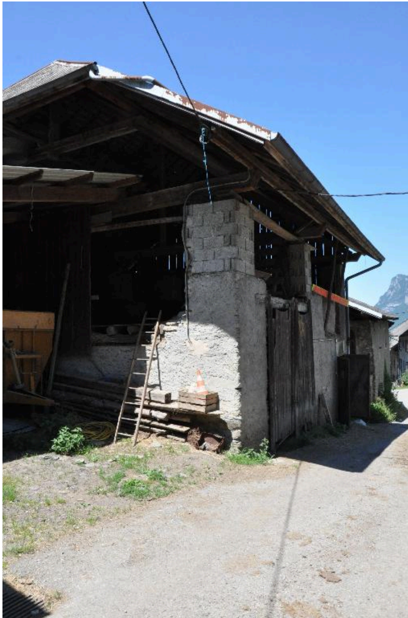
Pignon sud-est du bâtiment.
