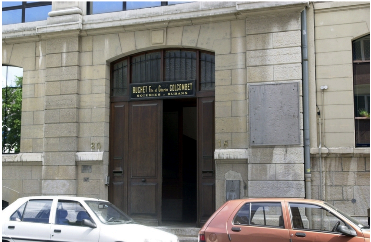
Entrée nord avec enseigne
