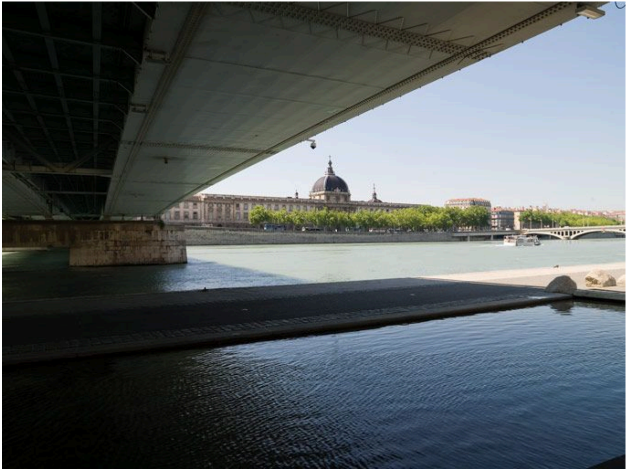
Le tablier du pont depuis le quai bas, rive gauche
