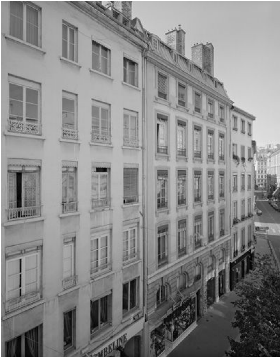
Vue générale de la façade
