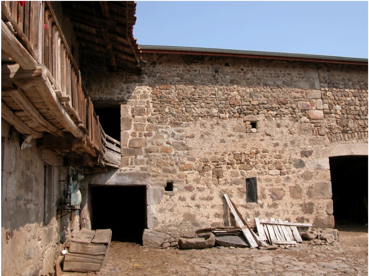
Vue de la grange-étable, depuis la cour.
