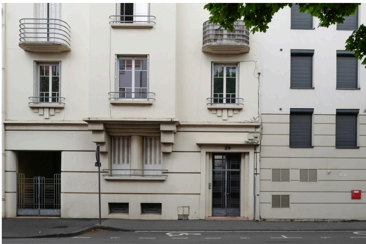
Détail d'architecture, façade, rez-de-chaussée et premier niveau
