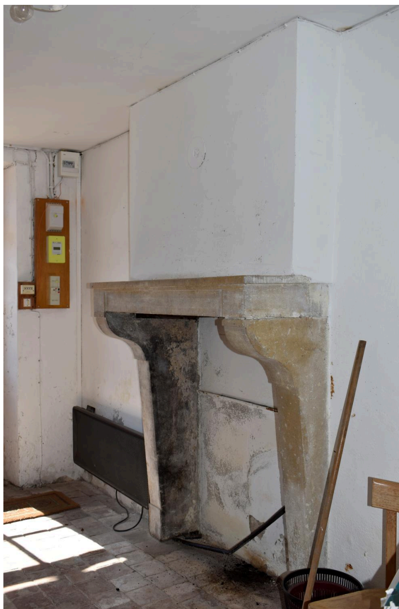
Vue de la cheminée de la cuisine.
