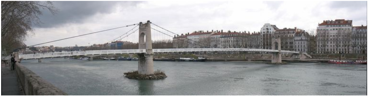
Vue panoramique, côté aval (depuis la rive droite)
